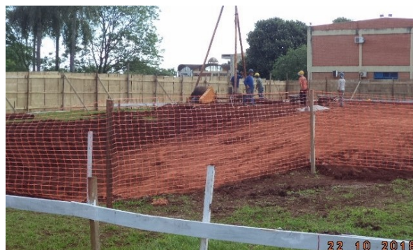
Imagem 10. Aspecto Geral da execução do Auditório – U U Dourados
