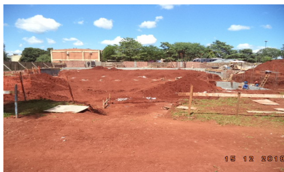
Imagem 11. Aspecto Geral da execução do Auditório - U U Dourados
