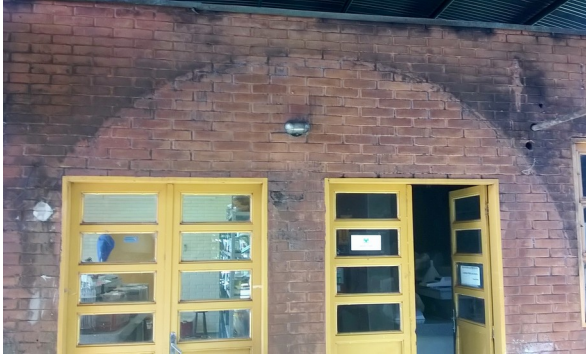
Imagem 17. Reforma e Cobertura do Laboratório de Biologia/CERNA - U U Dourados
