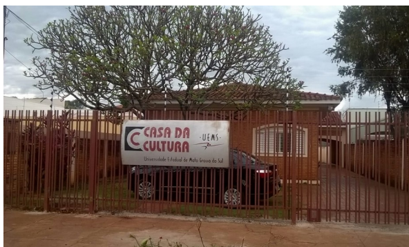
Imagem 05. Adequação da Cerca elétrica na Casa da Cultura/Dourados
