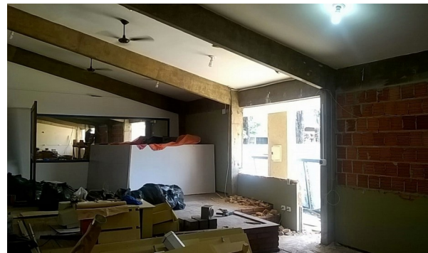
Imagem 04. Ampliação e Adequação do Guaraoby/Dourados
