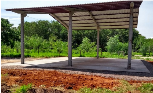
Imagem 01. Galpão de Máquinas – U U de Aquidauana
