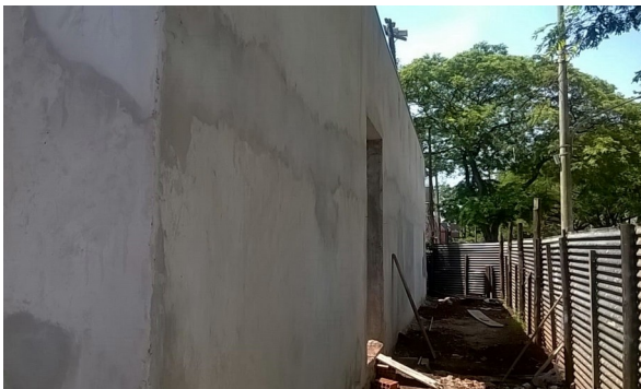
Imagem 03. Ampliação e Adequação do Guaraoby/Dourados
