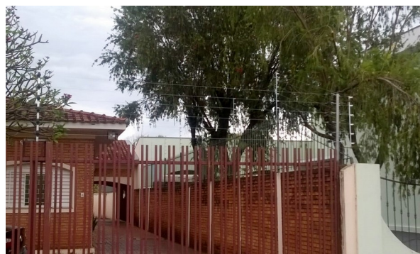
Imagem 06. Adequação da Cerca elétrica na Casa da Cultura/Dourados
