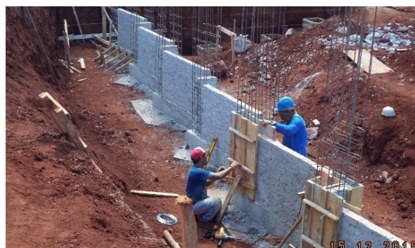
Imagem 12. Aspecto Geral da execução do Auditório – U U Dourados
