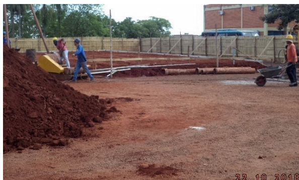
Imagem 09. Aspecto Geral da execução do Auditório - U U Dourados
