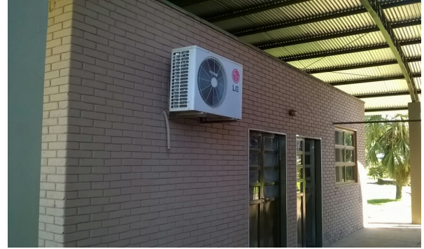
Imagem 18. Reforma e Cobertura do Laboratório de Biologia/CERNA - U U Dourados
