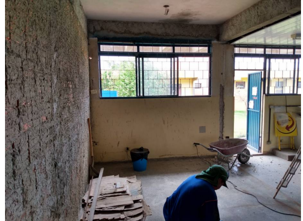
Imagem 28. Execução de parede de alvenaria e instalação de lousa no laboratório de Zoobotânica – U U de Dourados
