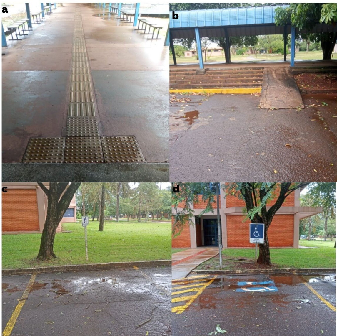
Figura 10 – Cenas dos ambientes e instrumentos de acessibilidade da UU de Dourados: a) Corredor entre o Bloco B e o Bloco E, b) Escada e rampa de acesso ao corredor que fica entre o bloco B e bloco E, c) Estacionamento vaga para idoso, e) Estacionamento vaga para cadeirante.
