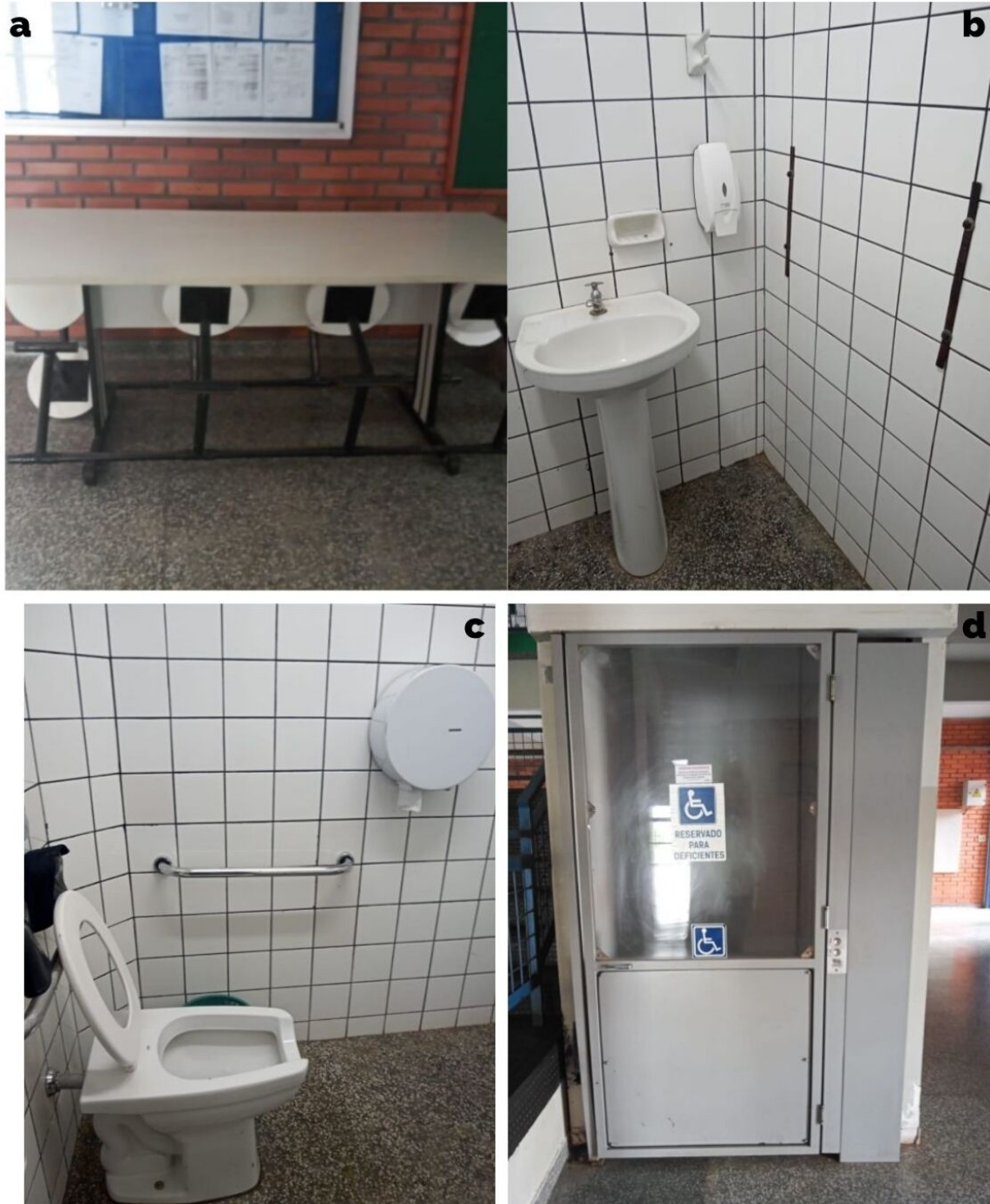
Figura 11 – Cenas dos ambientes da UU de Dourados: a) Mesas e assentos, b) Banheiro para cadeirantes, c) Banheiro para cadeirantes, d) Elevador..
