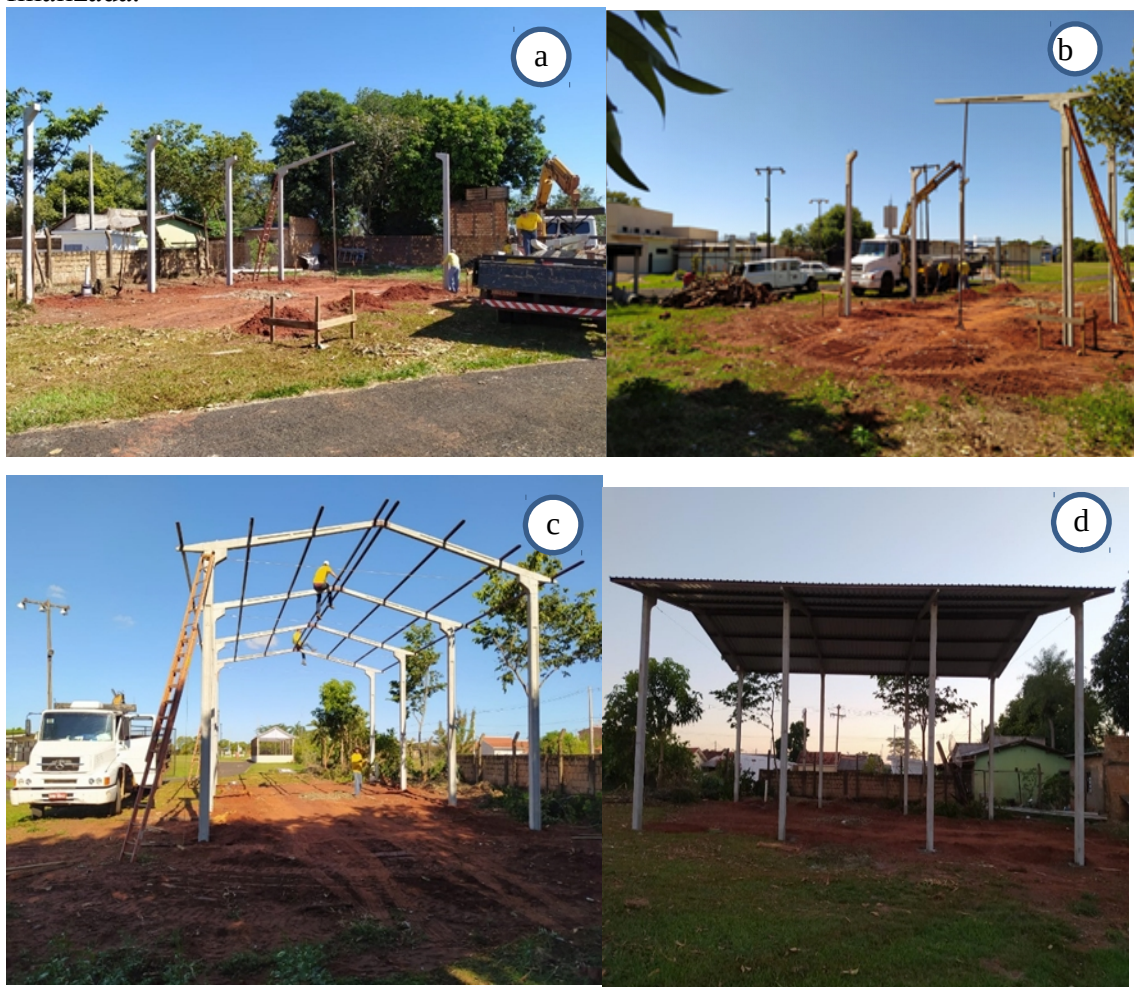
Figura 07 – Construção do Laboratório de Vermicompostagem. a) início da construção; b) colocação das estruturas; c) realização da cobertura do laboratório; d) construção não finalizada.
