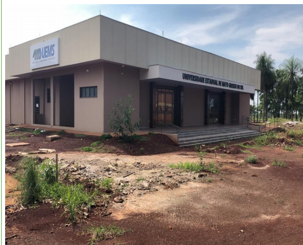
Figura 35 – Conclusão do Auditório - UU Dourados.
