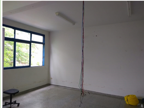
Figura 29 – PROE: Reestruturação física da pró reitoria e pintura, rede lógica, telefônica, instalação elétrica nova - UU Dourados.
