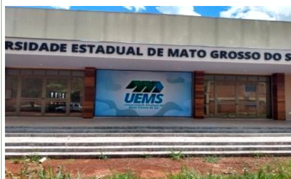
Figura 07 – Auditório: Instalação de painel em lona, letreiros e luminosos – UU Dourados.
