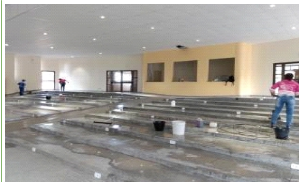
Figura 05 – Auditório: limpeza de piso e aplicação de resina para instalação de cadeiras – UU Dourados.
