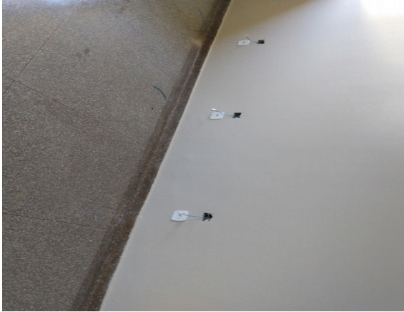
Figura 28 – PRODHS: Reestruturação física da pró reitoria e pintura, rede lógica, telefônica, instalação elétrica nova - UU Dourados.
