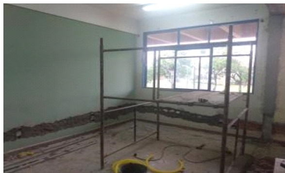
Figura 04 – Reestruturação assistência social (PROEC) Bloco A térreo – UU Dourados.
