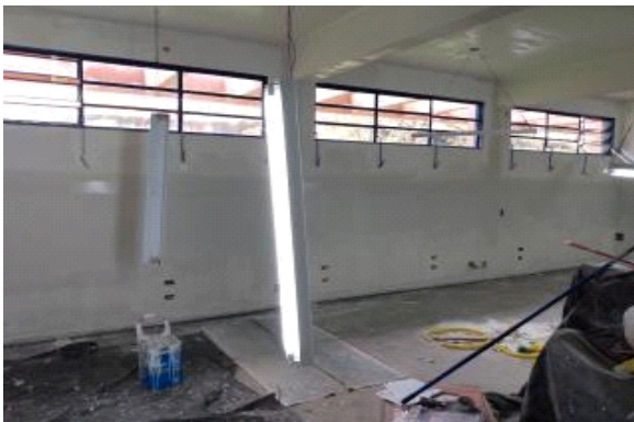
Figura 18 – DINFRA: Reestruturação física com construção da sala de diretoria, pintura, rede lógica, telefônica e elétrica nova - UU Dourados.
