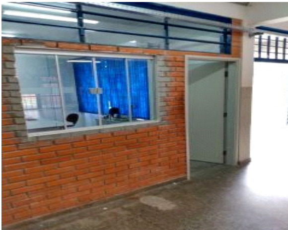
Figura 30 – Protocolo: Reestruturação física da pró reitoria e pintura, rede lógica, telefônica, instalação elétrica nova - UU Dourados.
