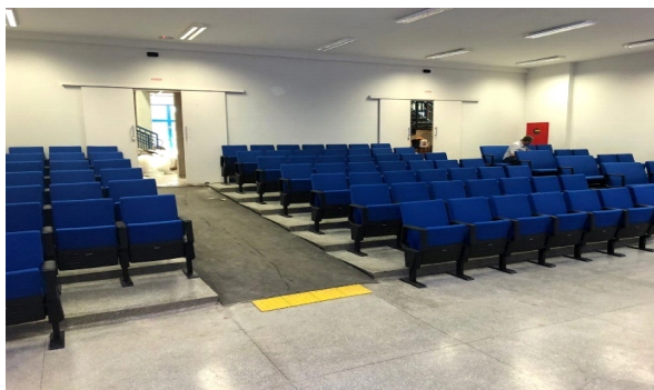
Figura 08 – Auditório Bloco G: Limpeza de piso e aplicação de resina para instalação de cadeiras – UU Dourados.
