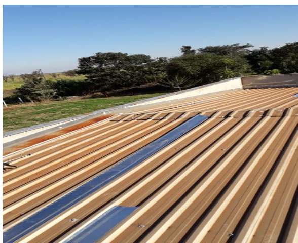
Figura 24 – LABECO: Consertos de telhado - UU Dourados.
