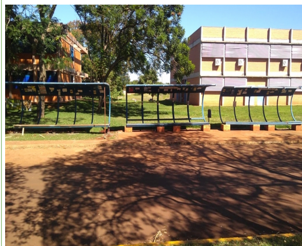
Figura 25 – Parada de onibus: Transferência de cobertura e revitalização de iluminação - UU Dourados.
