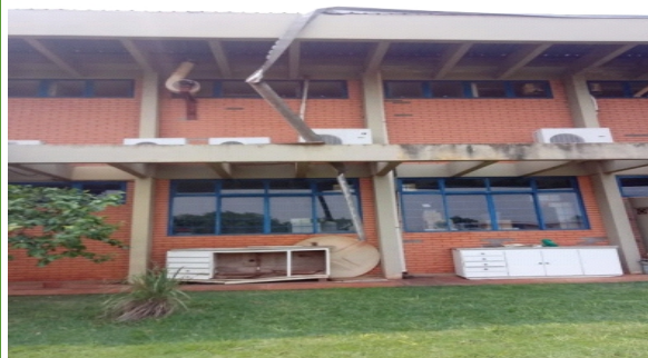
Figura 09 – Bloco C (CPIBIO): Instalação de pingadeiras e calhas novas e recuperação de rufos e instalação de novos (vendaval) - UU Dourados.
