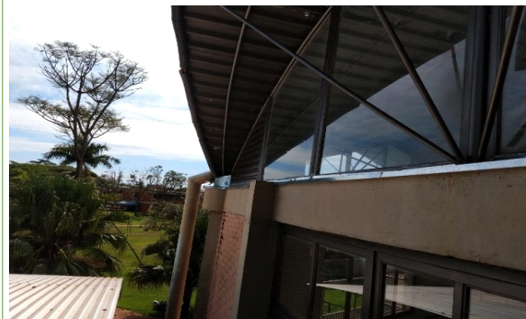
Figura 15 – CERNA – Instalação de rufos e pingadeiras – UU Dourados.
