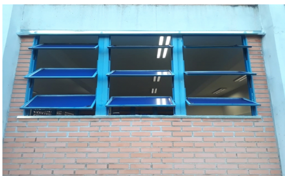
Figura 12 – Bloco G: execução dos primeiros serviços (pingadeiras e rufos nas janelas e portas)- UU Dourados.
