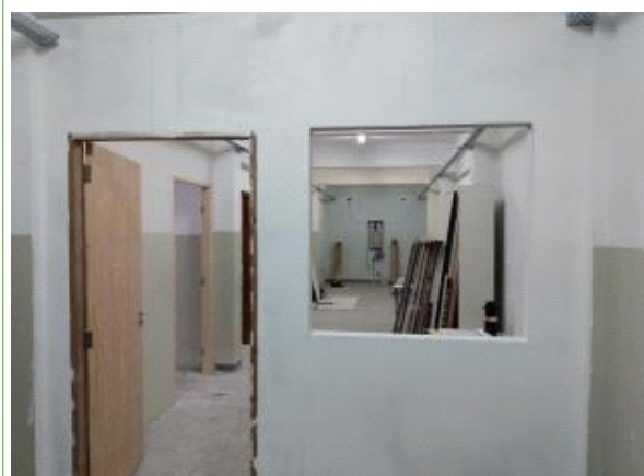
Figura 27 – PROAP: Reestruturação física da pró reitoria e pintura, rede lógica, telefônica, instalação elétrica nova - UU Dourados.
