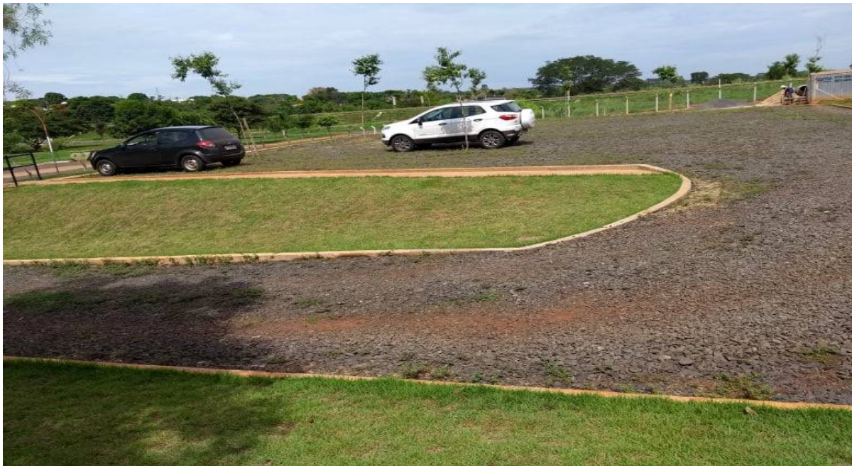
Imagem 41. Construção do novo estacionamento na UU de Paranaíba – UEMS/2018.
