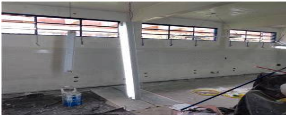
Imagem 26. Reestruturação física com construção da sala de diretoria, pintura, rede lógica, telefônica e elétrica nova – UU de Dourados.
