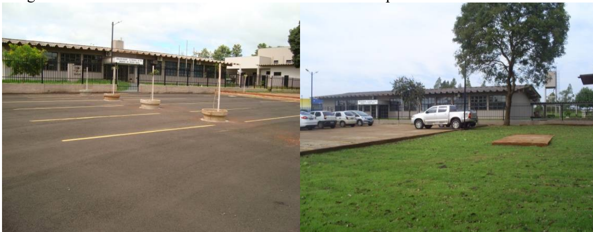
Imagem 38. Estacionamento da Unidade de Mundo Novo após a reforma – UEMS/2018.
