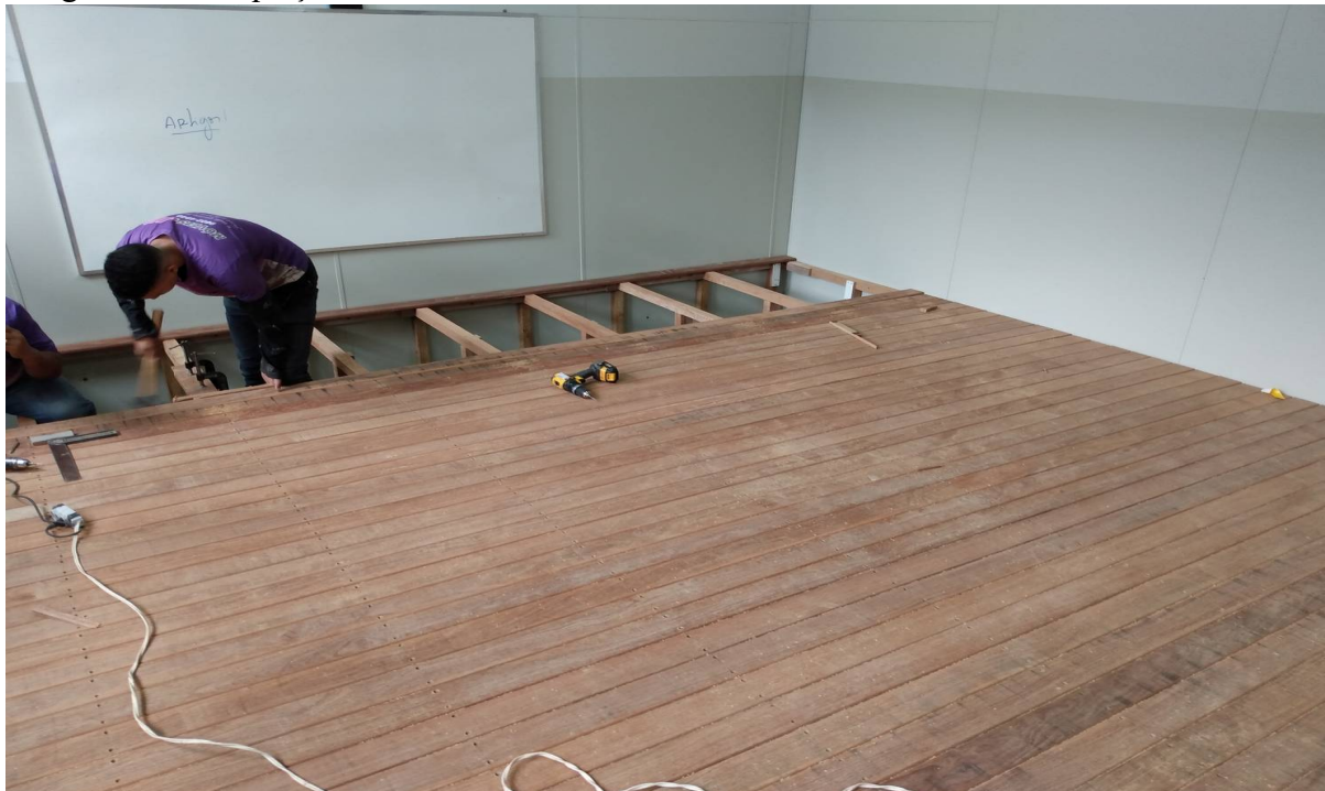
Imagem 21. Adequação do Laboratório de Física.
