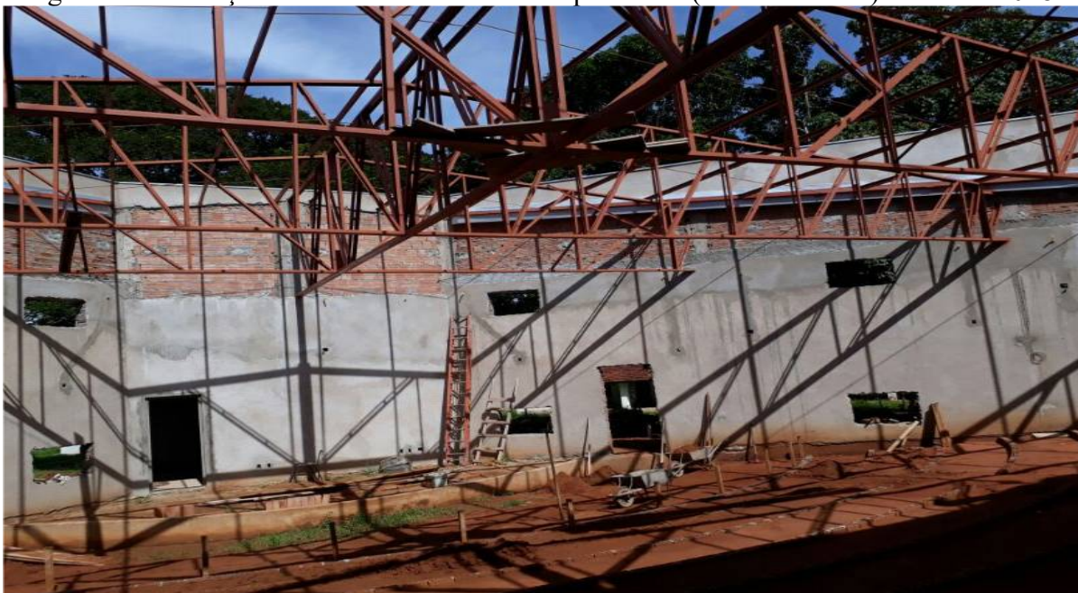
Imagem 1. Construção do Auditório da UU de Aquidauana (em andamento) – UEMS/2018.
