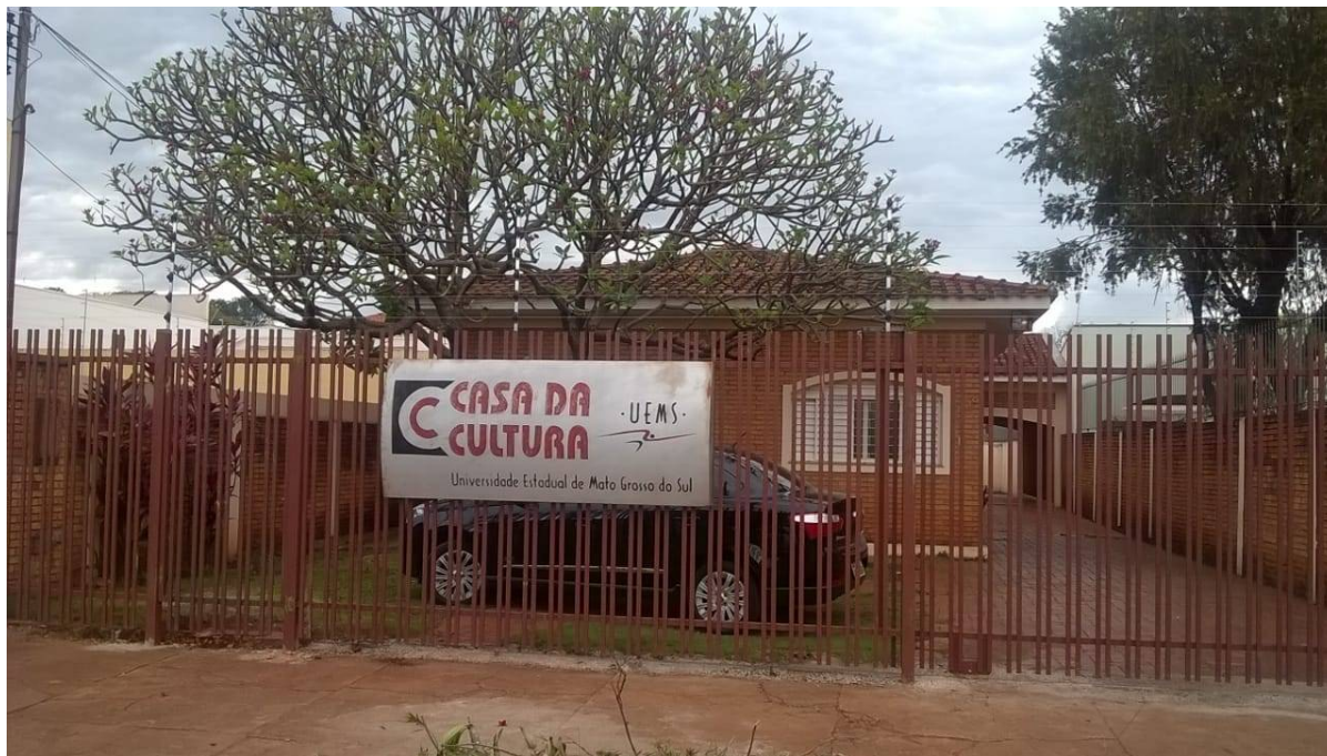
Imagem 17. Adequação da Cerca elétrica na Casa da Cultura/Dourados – UEMS/2018.
