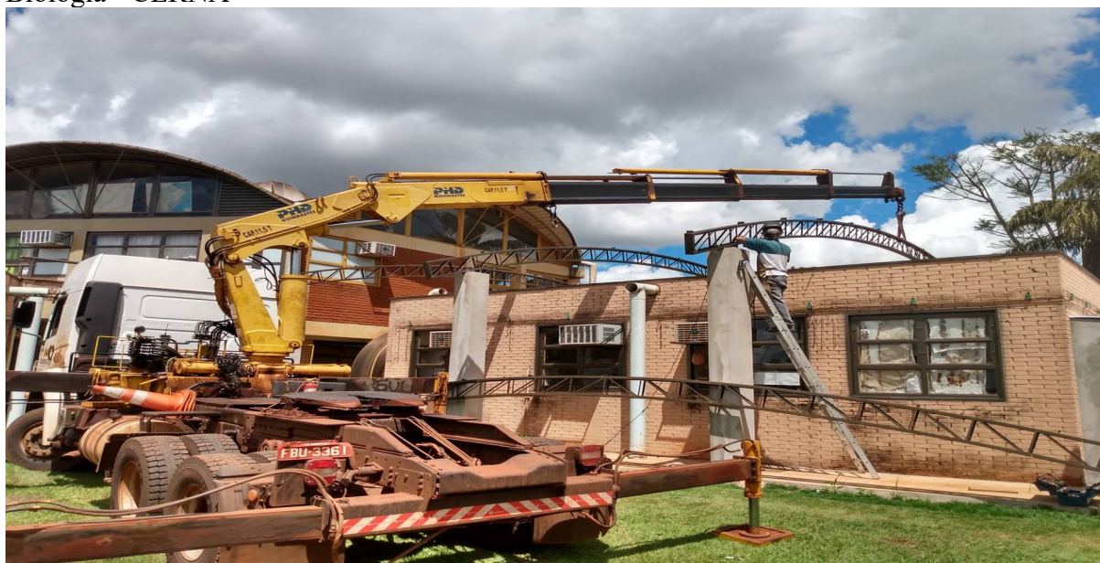
Imagem 22. Adequação Instalação de cobertura e reboco de pilares do Laboratório de Biologia - CERNA
