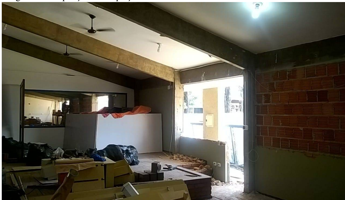
Imagem 16. Ampliação e Adequação do Guarobi/Dourados – UEMS/2018.
