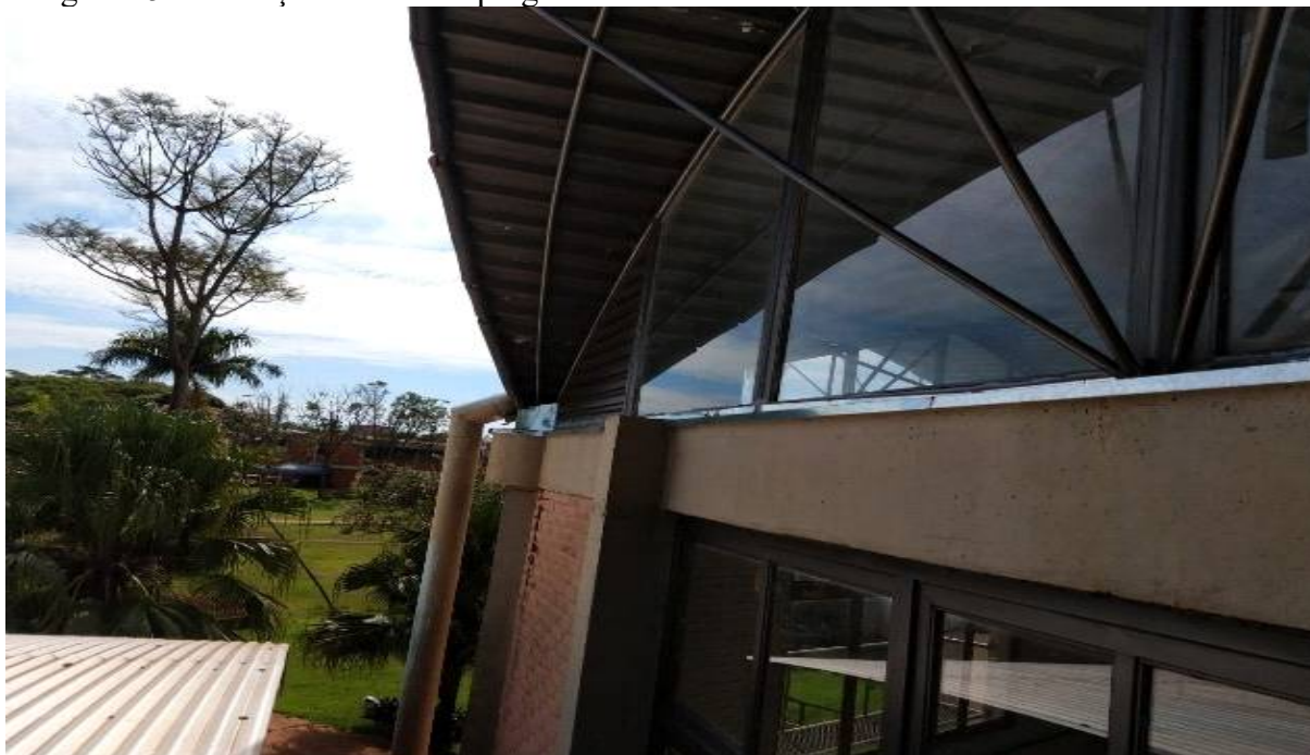
Imagem 25. Instalação de rufos e pingadeiras – UU de Dourados
