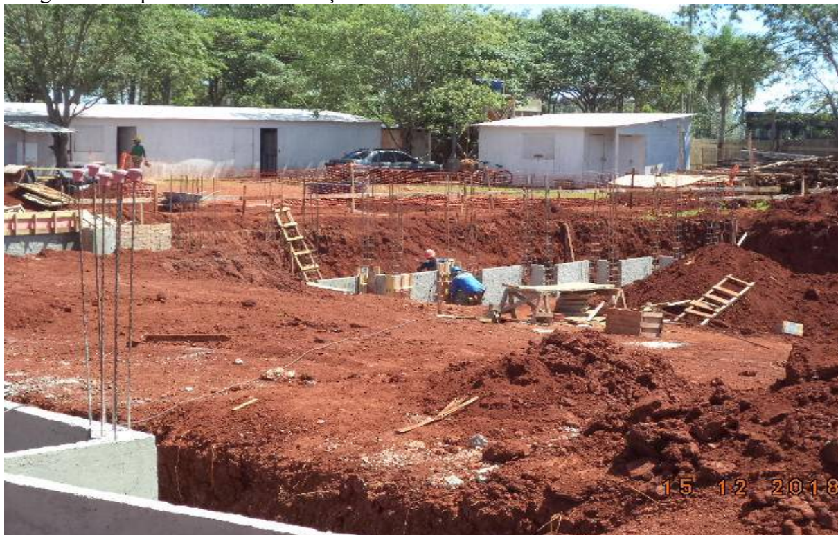
Imagem 19. Aspecto Geral da execução do Auditório – UEMS/2018.
