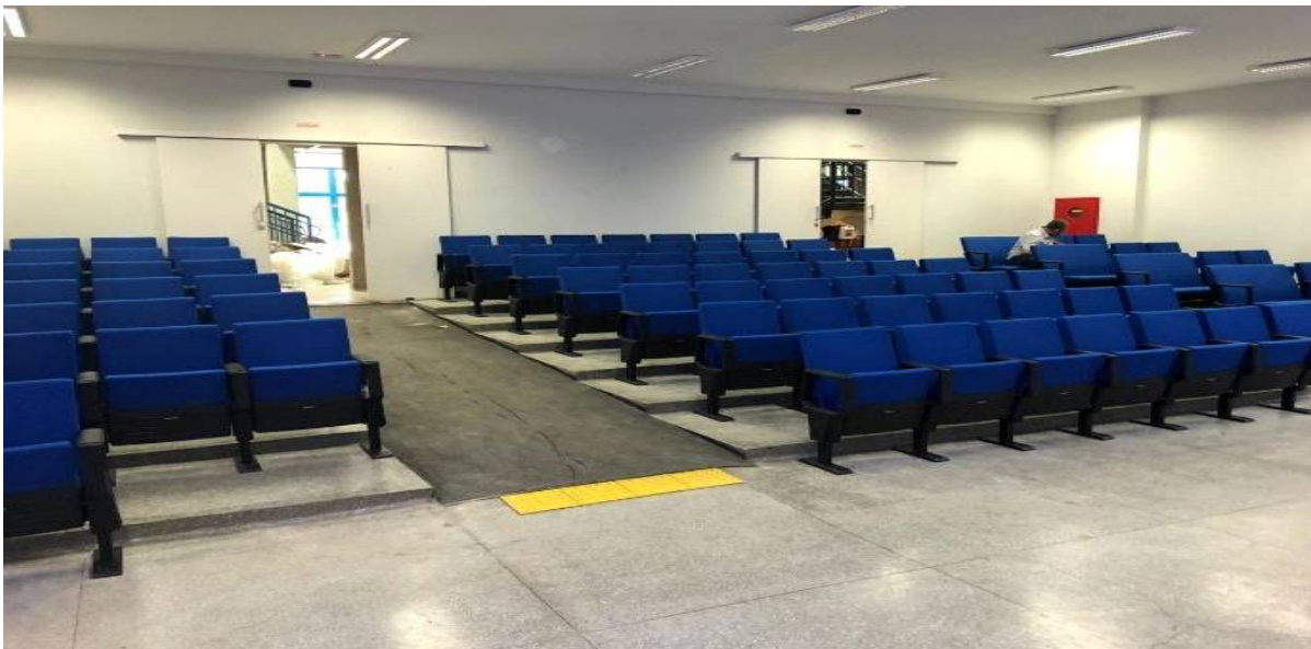
Imagem 36. Auditório Bloco G: Limpeza de piso e aplicação de resina para instalação de cadeiras - UU de Dourados.
