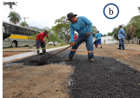
Figura 01 – Imagens das principais alterações/investimentos realizados na UU. a) Asfaltamento do estacionamento; b) Tapa-buracos; c) Construção de calçadas; d) construção de calçadas.
