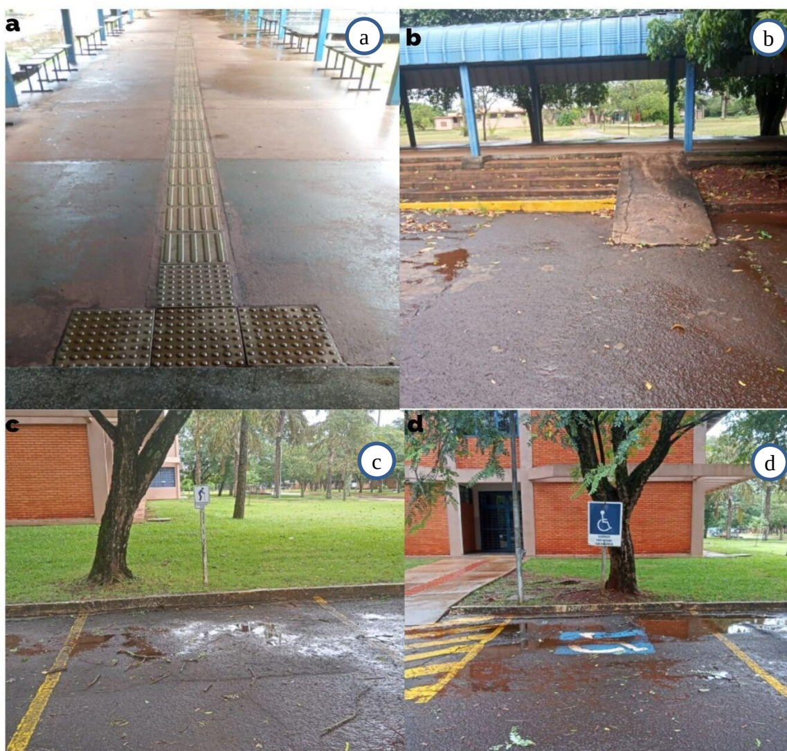
Figura 10 – Cenas dos ambientes e instrumentos de acessibilidade da UU de Dourados: a) Corredor entre o Bloco B e o Bloco E, b) Escada e rampa de acesso ao corredor que fica entre o bloco B e bloco E, c) Estacionamento vaga para idoso, e) Estacionamento vaga para cadeirante.
