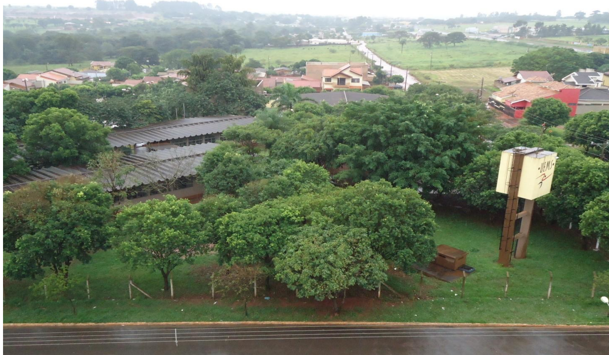
Figura 04 – Vista Aérea da UU de Nova Andradina.
