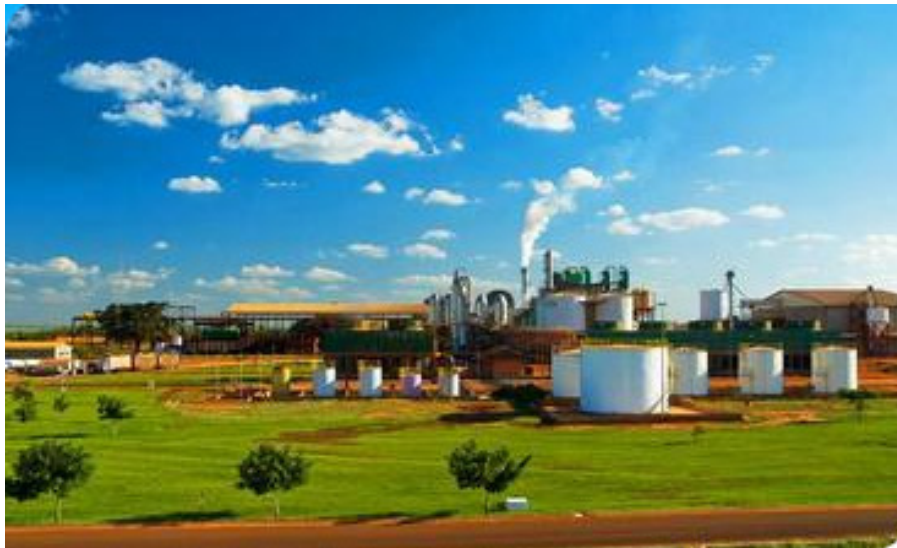
Figura 04: foto da Usina Eldourado Bioenergia – ETH, localizada no município de Rio Brillhante no Estado de Mato Grosso do Sul.
