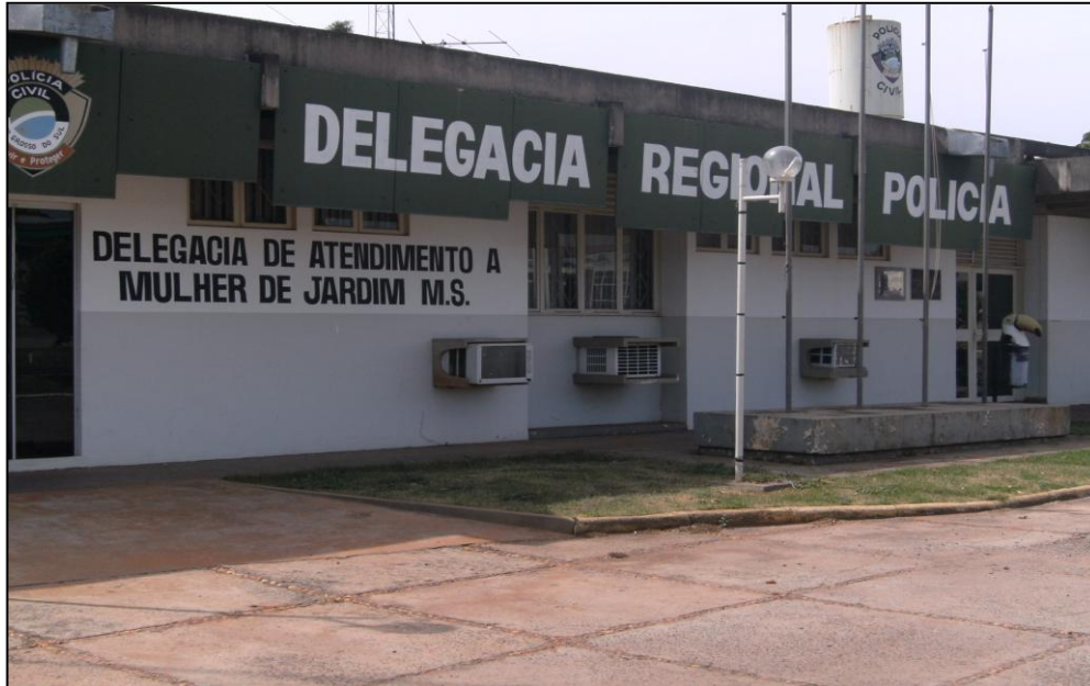
Foto 01: Fachada da DEAM de Jardim – MS. Fonte: NUNES, 2011.
