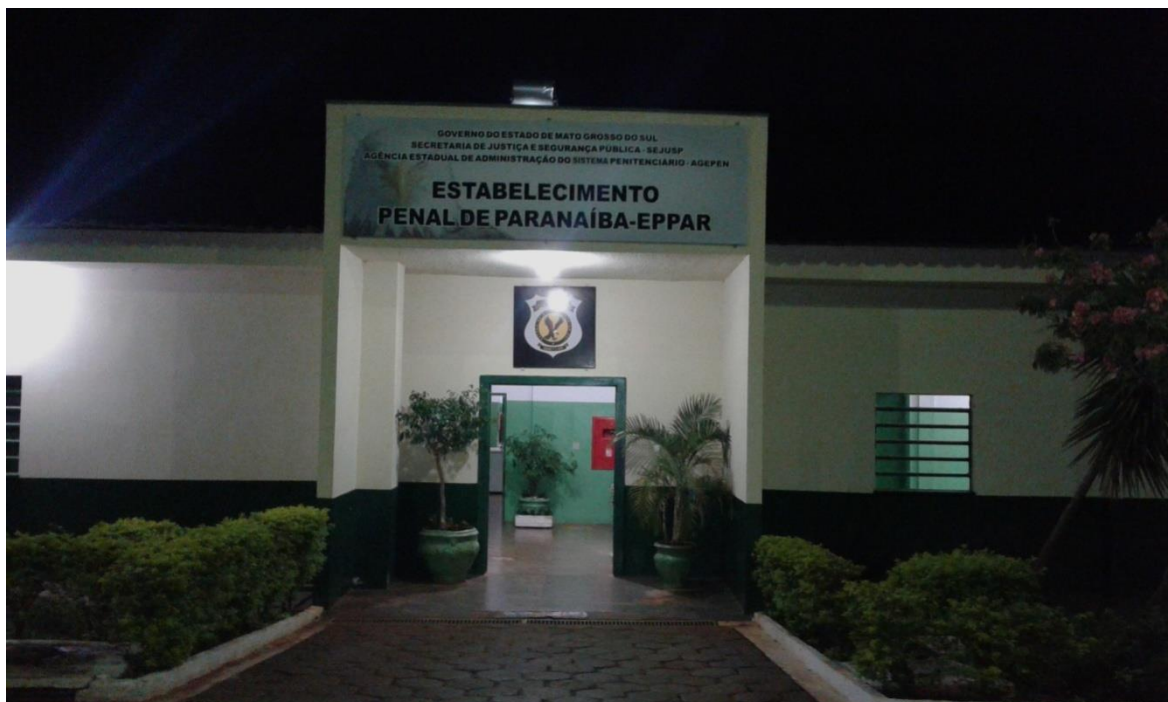
Foto da fachada do PPar
