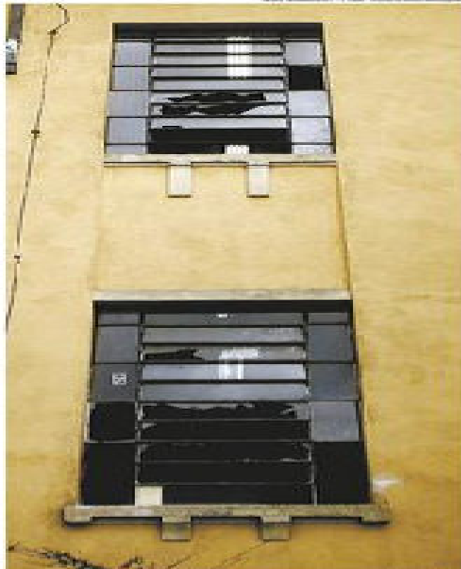
Figura 2 – Depredação na EE. Amadeu Amaral.
