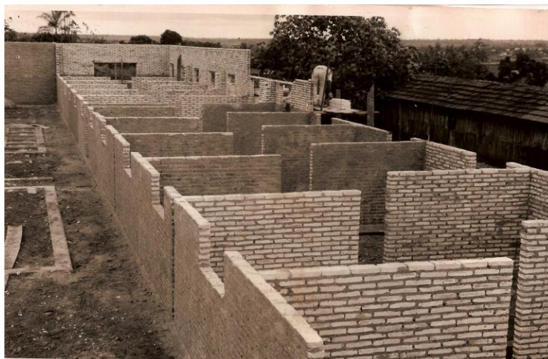
Fig. 3: construção do asilo (Fonte: Acervo do Asilo Santo Agostinho)
