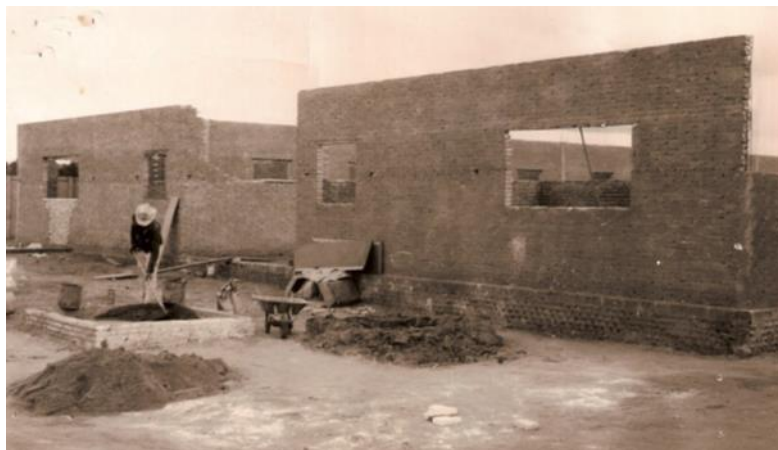
Fig. 2: construção do asilo (Fonte: Acervo do Asilo Santo Agostinho)
