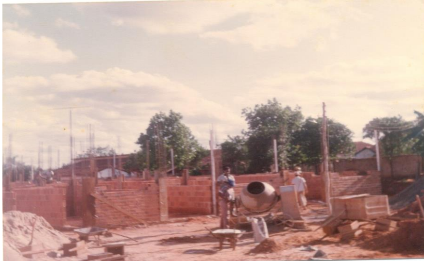
Figura 6: Construção em andamento do prédio, 1983.
