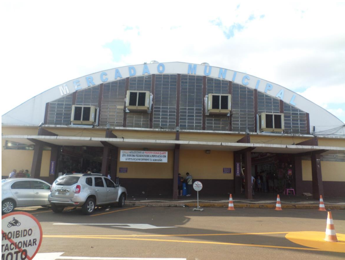
Figura 4 – Fachada do Mercado Municipal Antônio Valente, em 2016. Fonte: a autora
