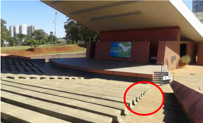
Figura 10 - Arquibancada da Concha Acústica, detalhe da ausência de espaço reservado para PCR e PMR Fonte: Autora, 2016
