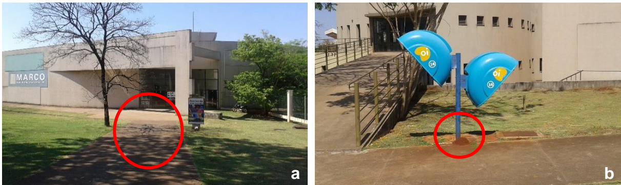
Figura 13 - Fachada do MARCO: a) Calçada de acesso, destaque para o piso regular; b) Telefone público acessível, destaque para a instalação fora da calçada, sobre a vegetação Fonte: Autora, 2016
