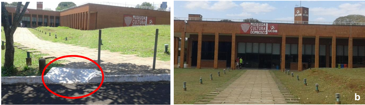
Figura 14 - MCDB: a) Rampa de acesso não está centralizada em relação à calçada (destaque); b) Calçada de acesso em placas de concreto Fonte: Autora, 2016
