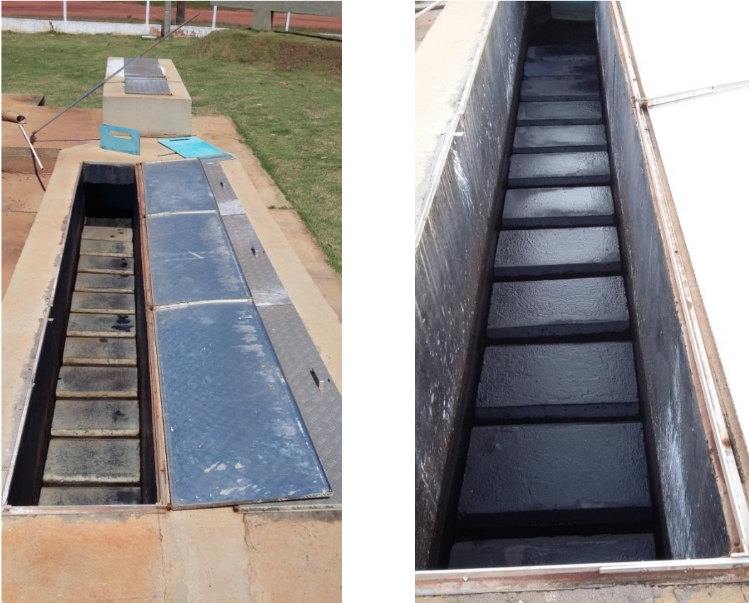
Figura 4 – Visão do desarenador utilizado na ETE Iguatemi.
