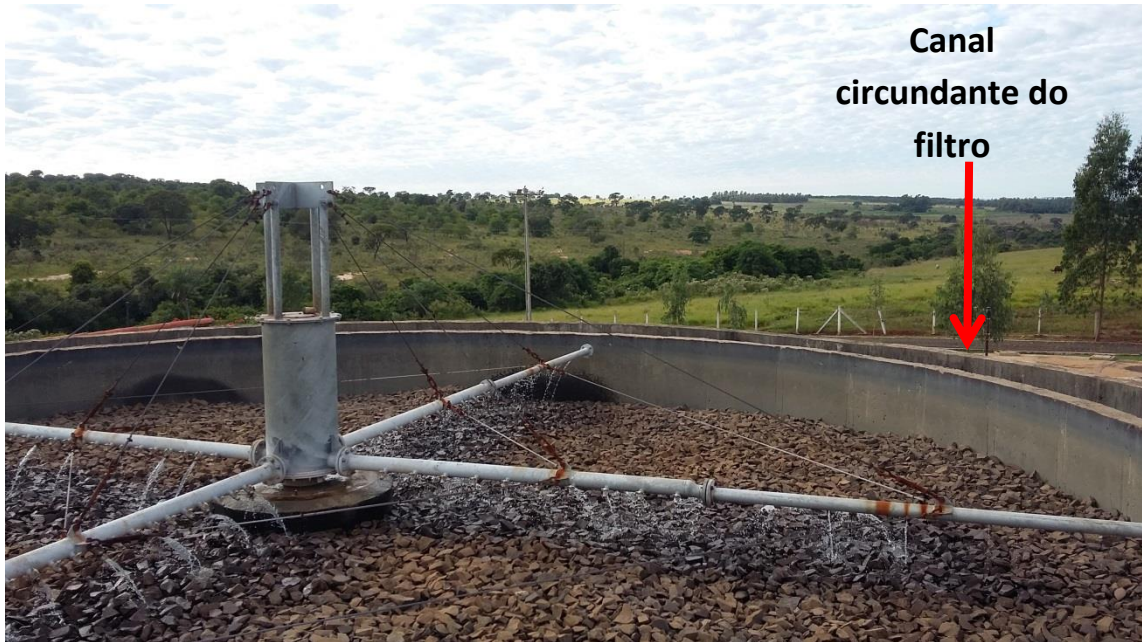
Figura 6 – Imagem do filtro biológico demonstrando a área de escoamento do filtro
