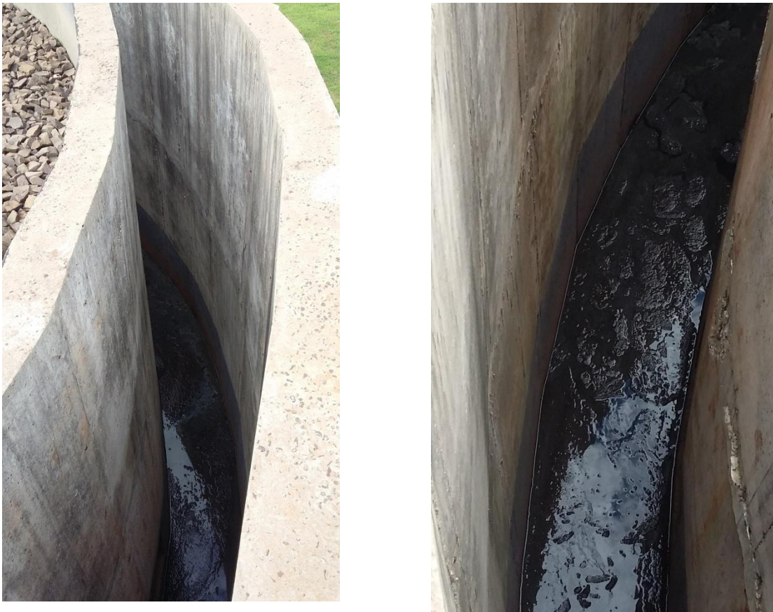
Figura 7 – Imagem do acúmulo de areia no canal do filtro biológico caracterizado como espaço confinado
