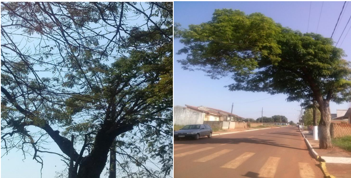
Figura 12. Caesalpinia peltophoroides na Avenida Industrial encostando-se à rede elétrica e danificada pelo sistema de poda adotado
