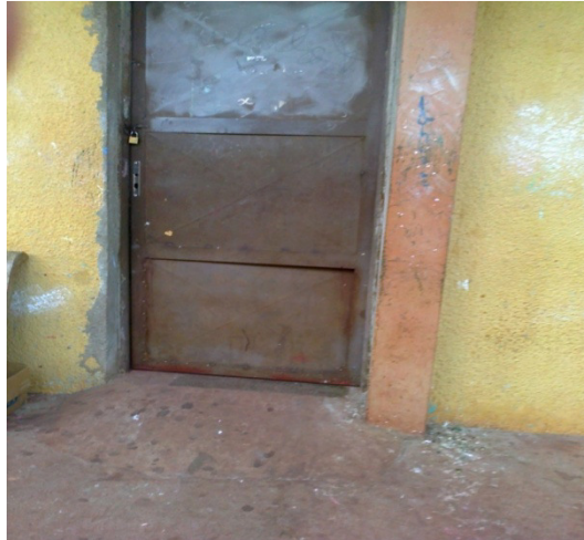
Figura 2- Fonte: (CAUZ, 2015). Porta da sala de aula.
