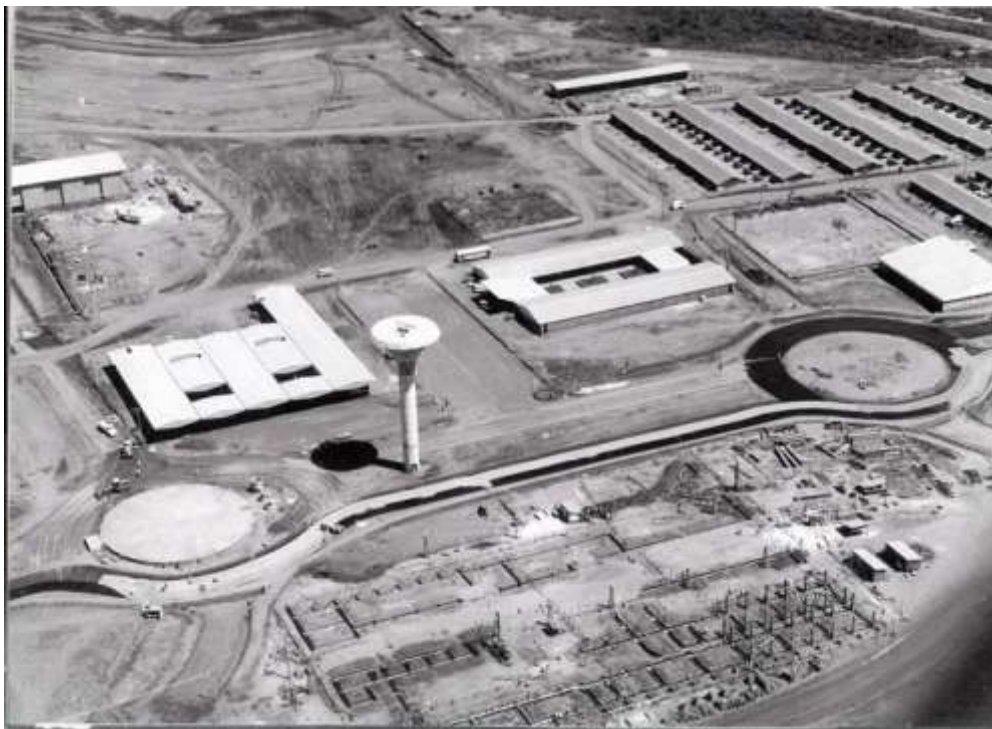
Figura 4 – Vista Panorâmica de Ilha Solteira em construção – Década 1960
