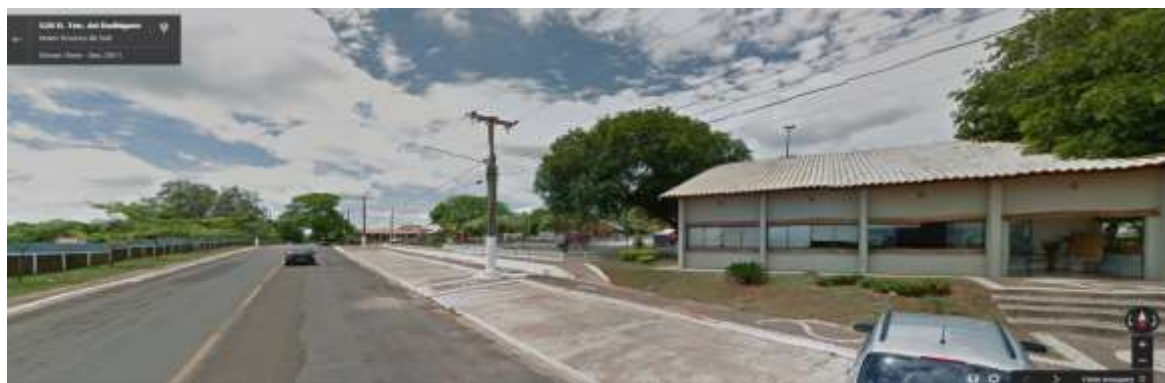
Figura2: Imagem da área onde foi construída a biblioteca, atualmente CAT.
