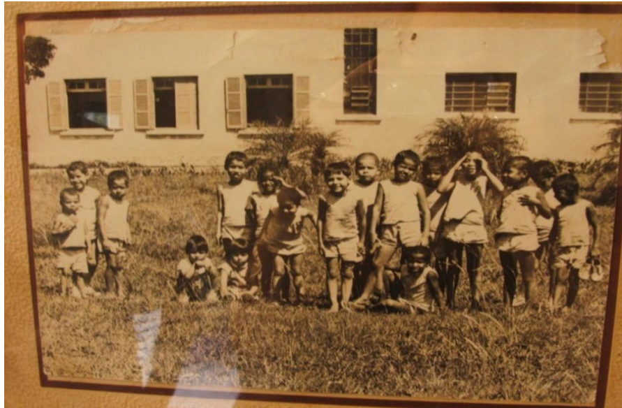
Figura 17 – Prédio visto por fora – 1945
