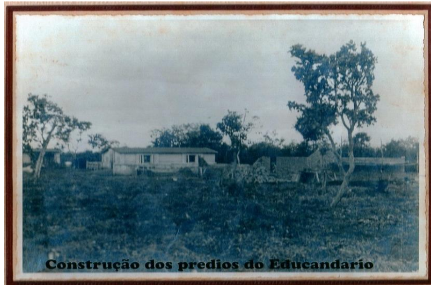
Figura 3 - Início das obras em Campo Grande/MT – 1941
