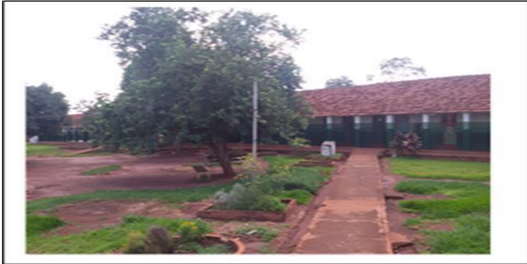
Figuras 8: Entrada da Escola Municipal Iraí Ferreira de Souza
