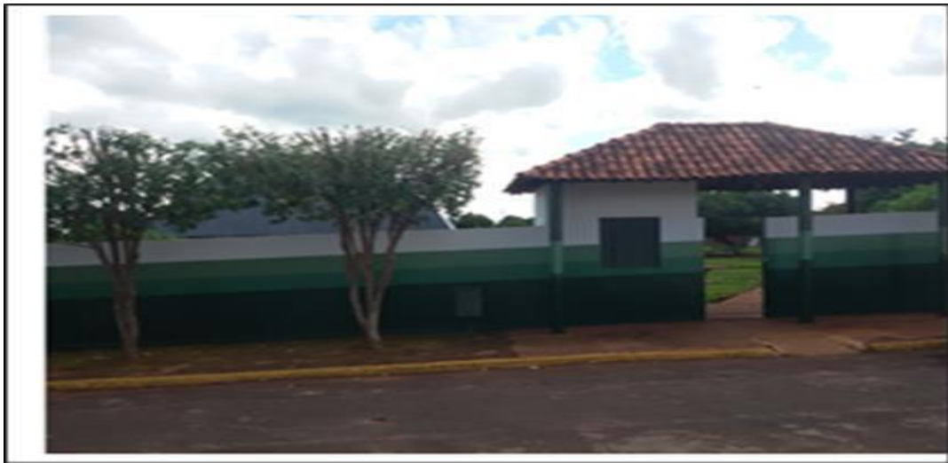
Figuras 7: Entrada da Escola Municipal Iraí Ferreira de Souza
