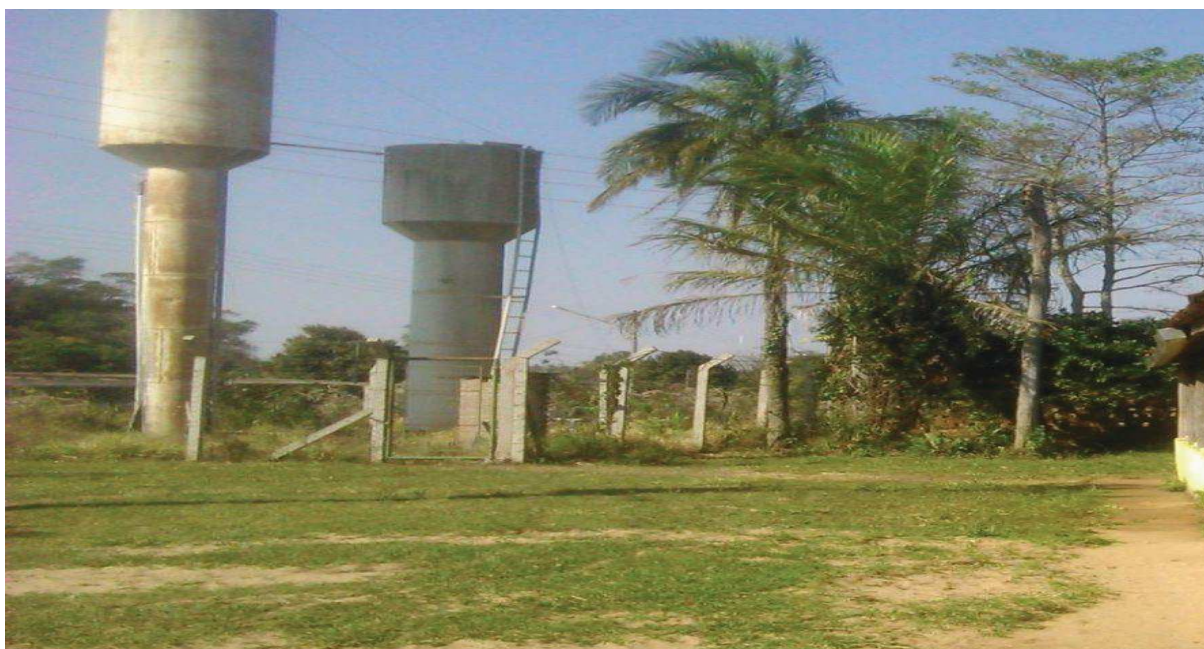
Figura 05. Reservatório de água do Assentamento Guaicurus
