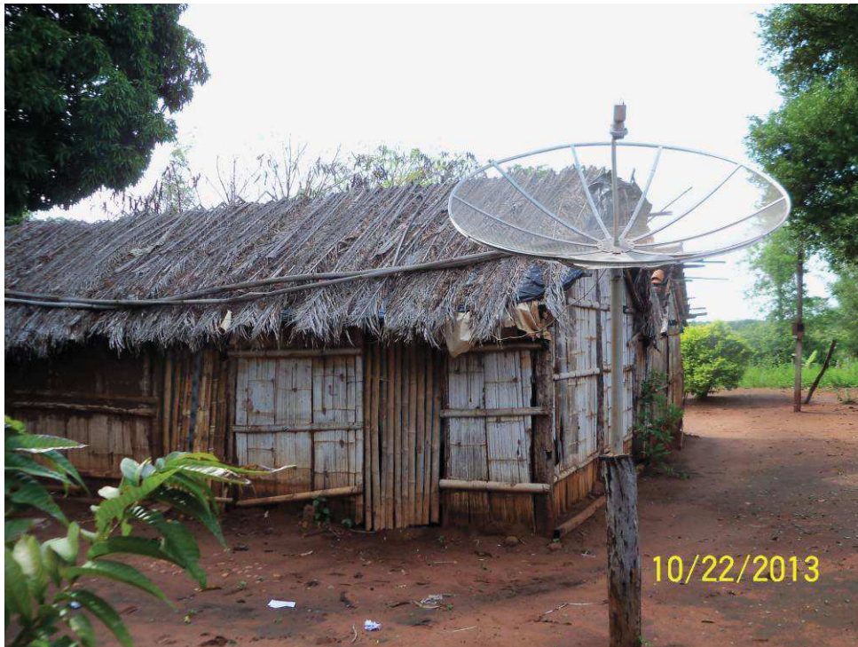
Figura VII – Casa tradicional Terena, feita de Taquara batida e coberta de palha de Acuri ou Bacuri, material retirado do Barreiro. Fonte: PAULO, E.F. Pesquisa de Campo, 2013.
