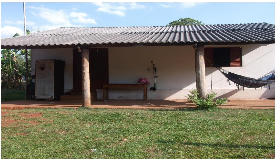
Foto 10. Casa de alvenaria Foto: RSouza, 2011.
