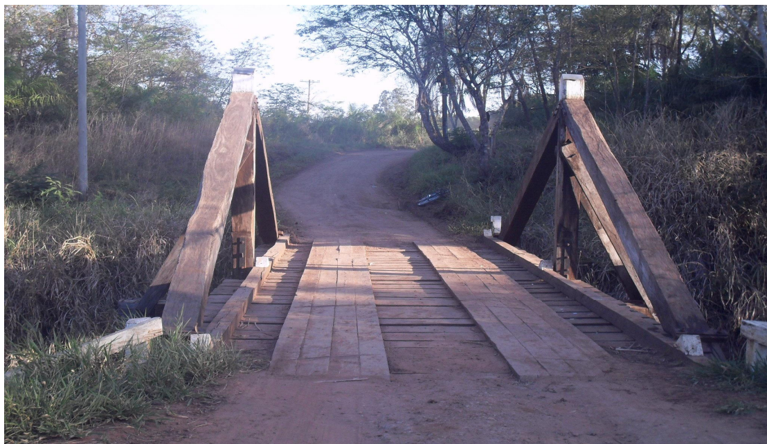
Foto 1. Ponte sobre o rio Urumbeva Foto: RSouza, 2011.
