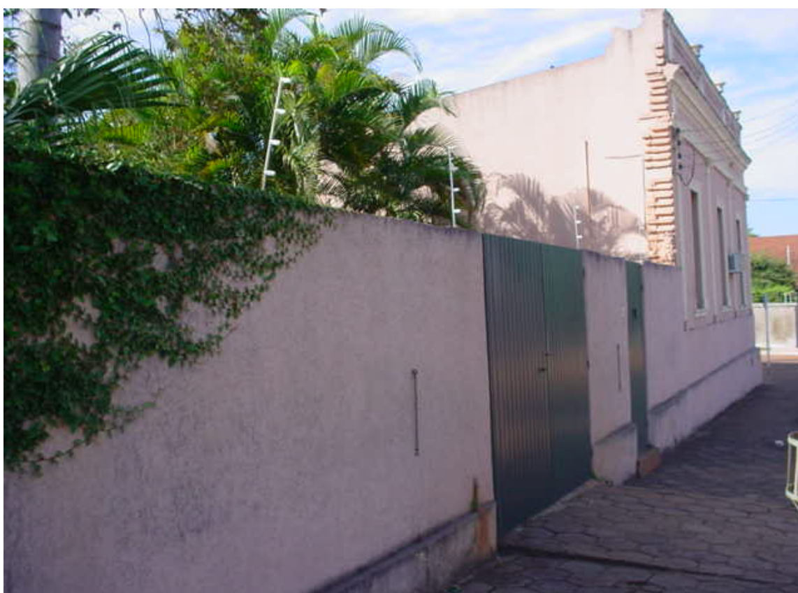
Figura 09: Edificação antiga com mecanismo de segurança – cerca eletrificada. Fonte própria 2010.
