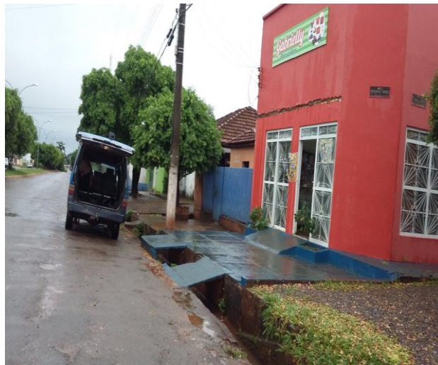
Figura 19. Valeta para escoamento pluvial
