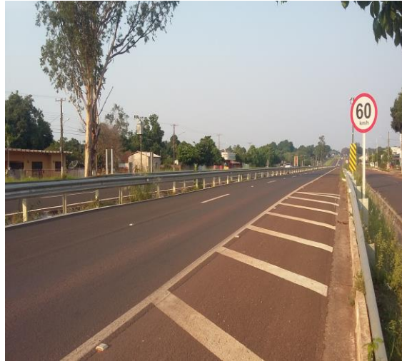
Figura 5. Vista parcial da Rodovia- BR-060 (Av. Santa Terezinha)
