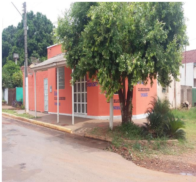
Figura 23. Rampa com acesso a calçadas irregulares
