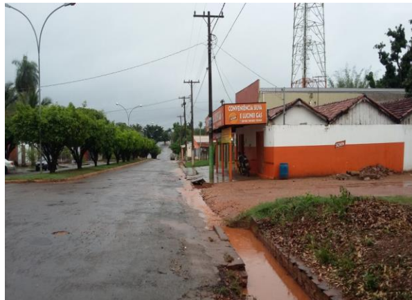
Figura 21. Acúmulo de água na rua Presidente Vargas
