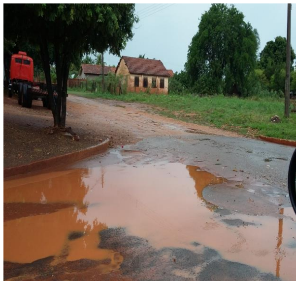
Figura 15. Acúmulo de água pluvial nos buracos da via
