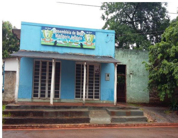
Figura 9. Vidraçaria na Rua Macias Barbosa
