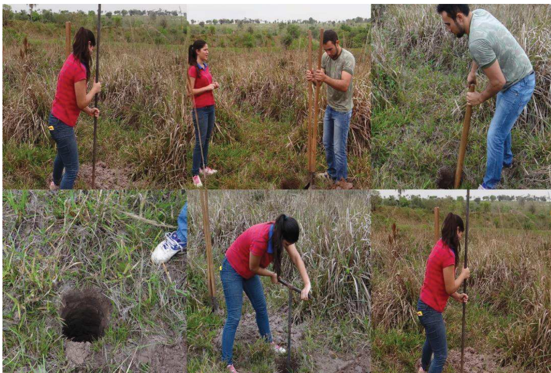
Figura 5 – Sequência de cenas do processo de produção do ponto de coleta de água. É possível observar (do topo a esquerda para a base na direita) a utilização da cavadeira e trado.
