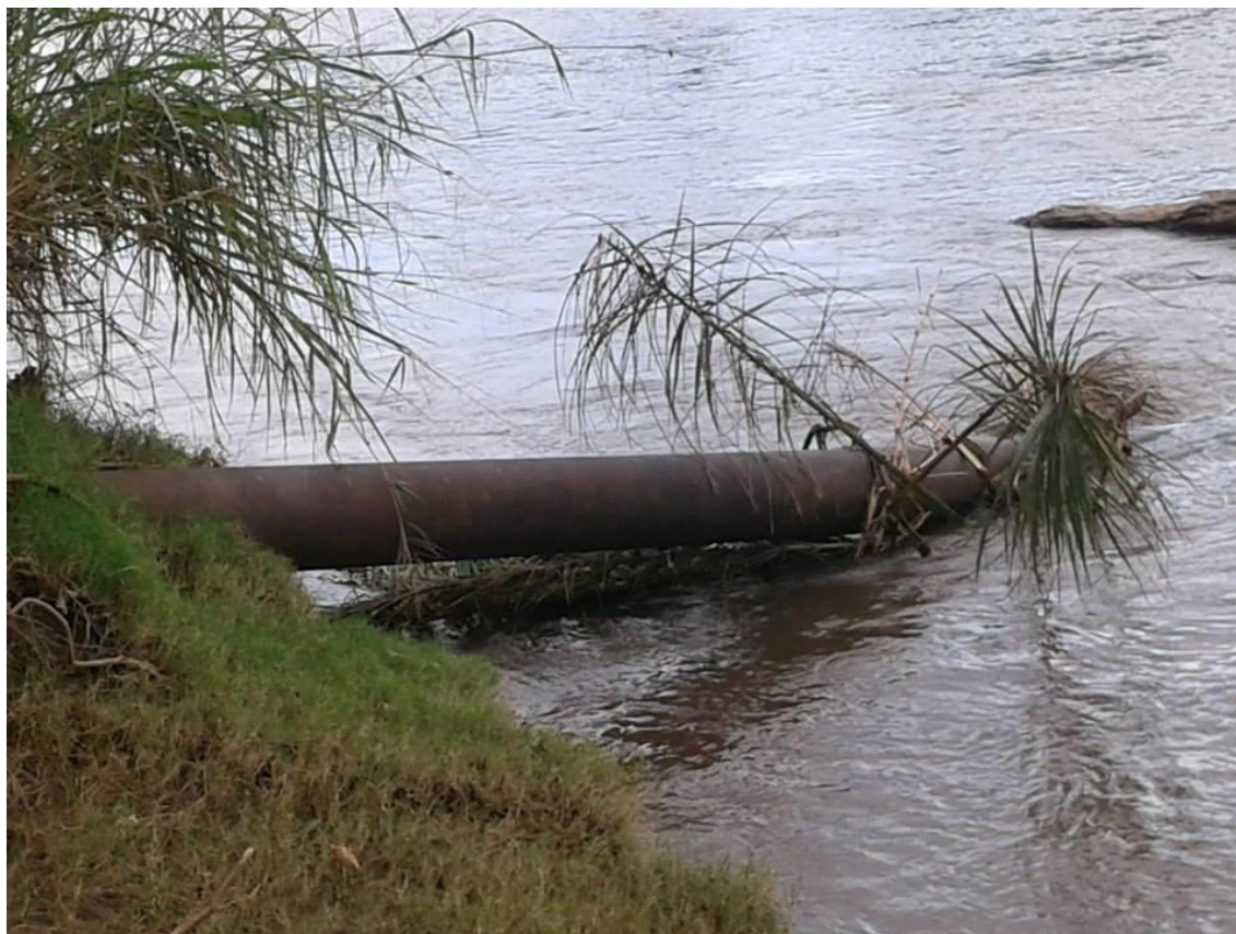
Figura 23 – Local de lançamento de efluentes da ETE (Estação de Tratamento de Esgoto), Jardim, MS.
