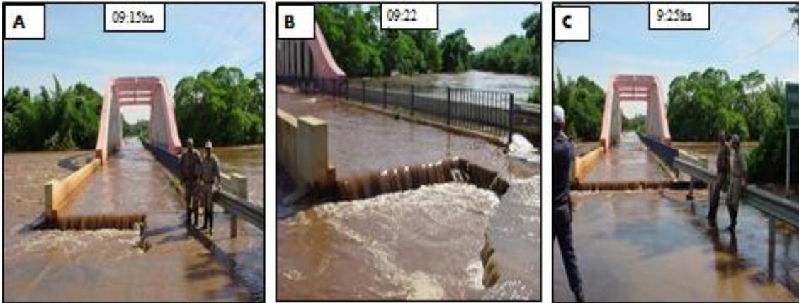
**Figura 17-** Sequência de imagem da danificação da ponte velha que liga Jardim e Guia Lopes da Laguna, BR267.
