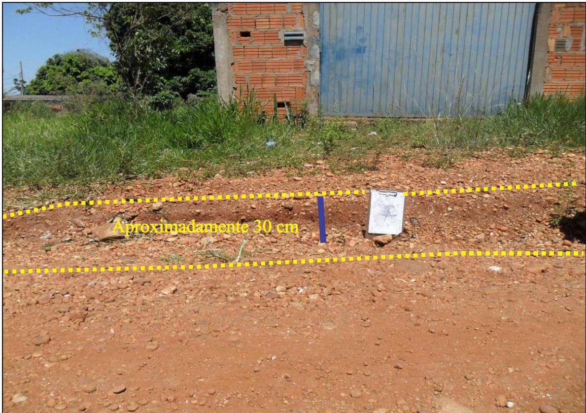
**Figura 16** – Rebaixamento de via pública realizado para obliteração de erosões por tratores.
