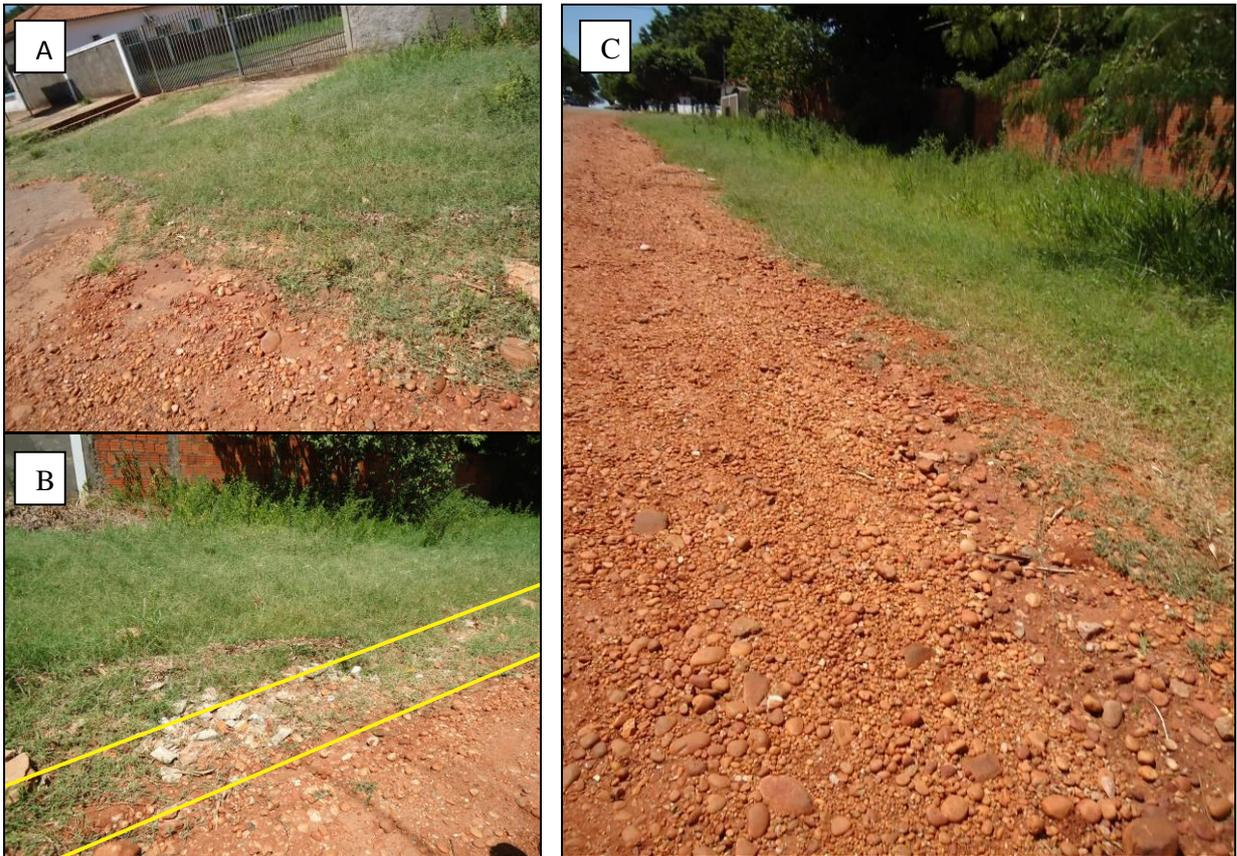
**Figura 9** – Erosões na área central da cidade. A) Ponto da Rua Tenente Ary Rodrigues mostrando o fim da pavimentação asfáltica e início da área sem pavimentação; B) Linha pontilhada demonstrando início da concentração do fluxo de água; C) Marcas no solo de erosão laminar.
