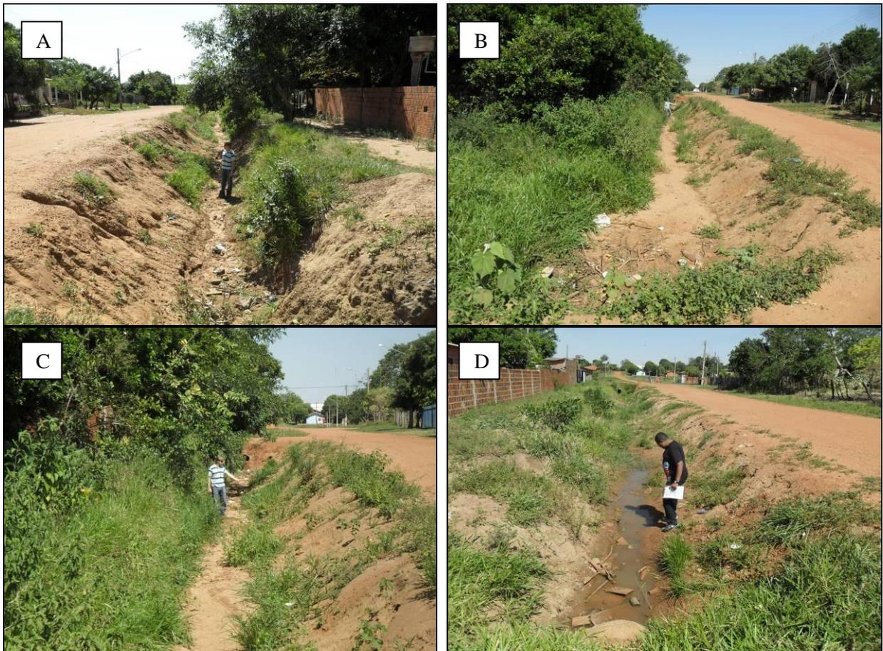
**Figura 14** – Jusante da área alagada. A) Erosão localizada na Rua Rio Verde; B) Ampliação da valeta devido aos sucessivos períodos chuvosos; C) Incisão vertical e lateral; D) Presença de água na erosão, foco de insetos.
