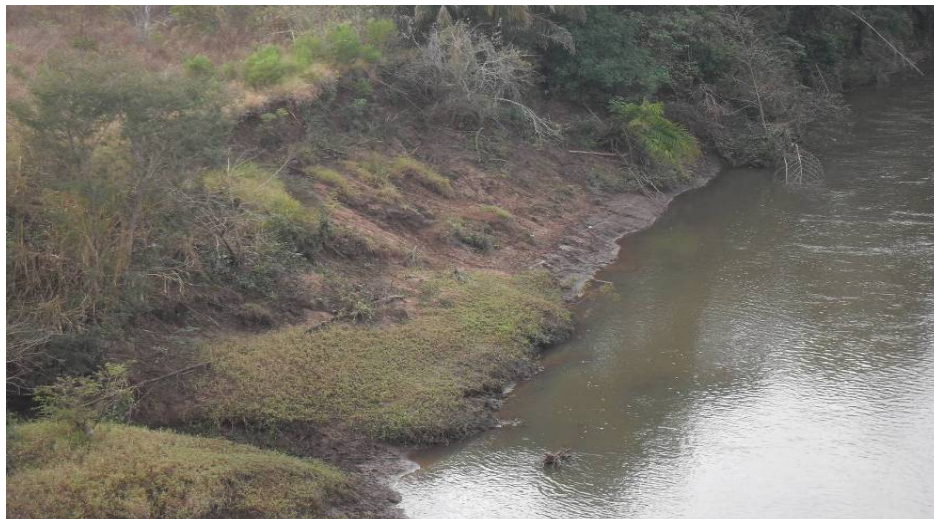
Figura 8 - Visão aproximada da margem direita do rio Miranda. A ausência de vegetação denota um estado de fragilidade e necessidade de recuperação da área com presença de processos de erosão marginal.
