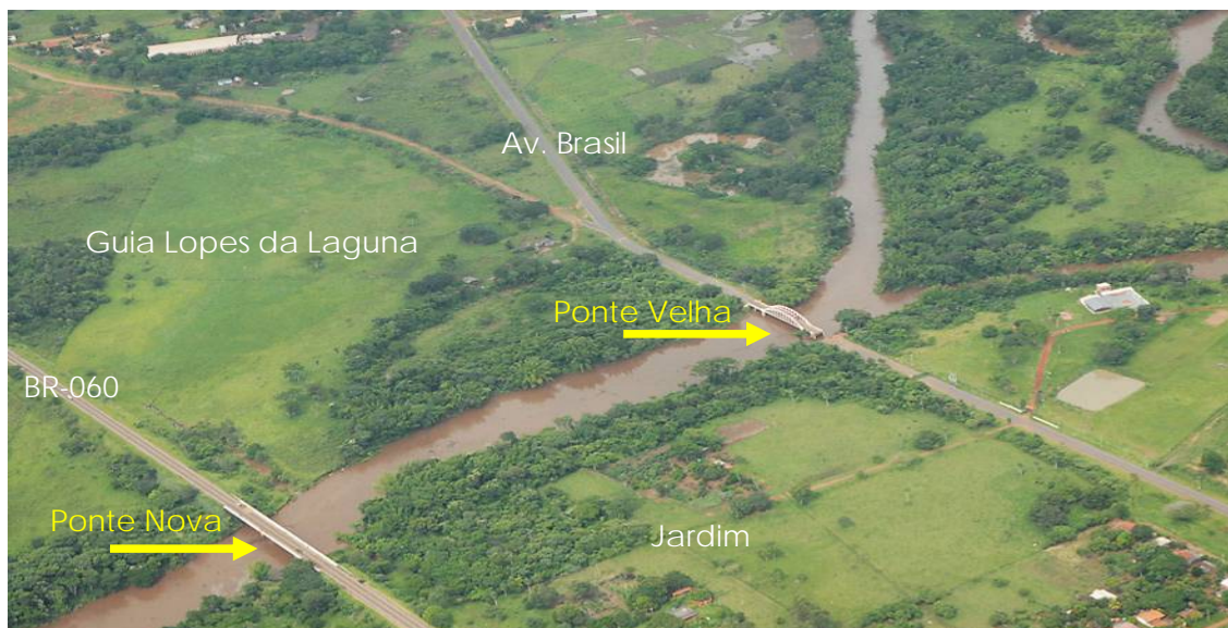
Figura 3 – Área estudada entre as pontes que ligam as cidades de Jardim e Guia Lopes da Laguna. Fonte: GERARD MOSS e MARGI MOSS, 2007.
