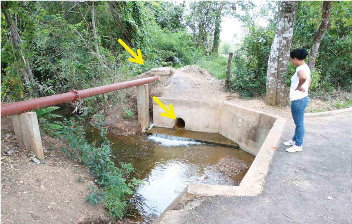
Figura 15 - Área do córrego Restinga no Jardim Boa Vista/ Solar dos Lagos. Em destaque pelas setas, estão as galerias de escoamento de água pluvial e rede de água que cruza o canal. Fonte: Autora
