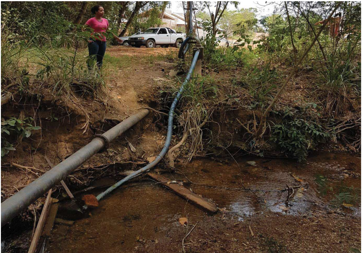
Figura 26 - Estrutura montada para abastecer caminhões com água do córrego Restinga.
