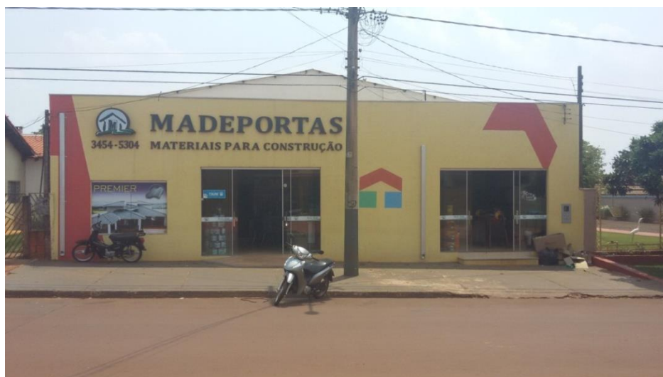
Figura 1: Fachada da empresa Madeportas.
