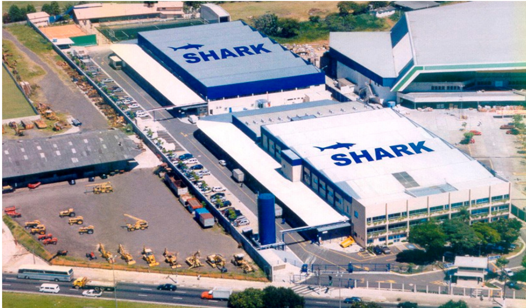
FIGURA 7 - Vista Aérea da Matriz (São Paulo-SP)
