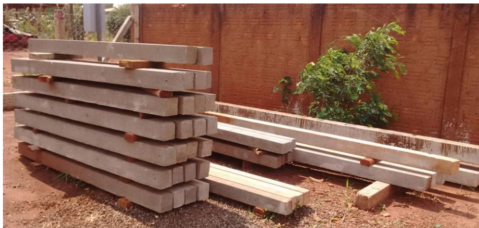
FIGURA 4: FABRICAÇÃO DE POSTES DE CONCRETO
