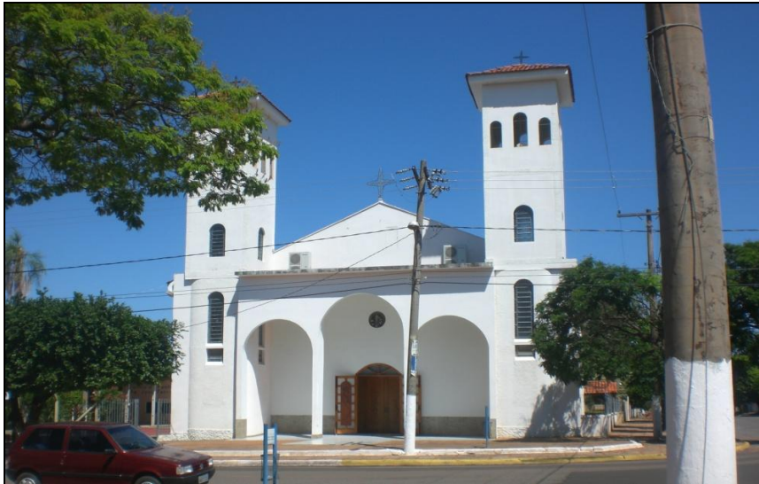
Foto: Fachada atual da Igreja Santo Antônio em 2010 Fonte: ROSA, Jaquerson C.
