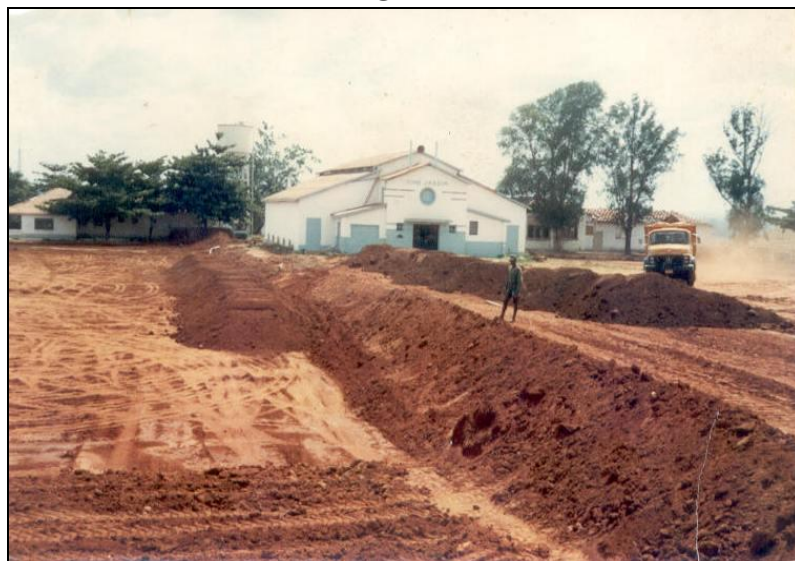
Foto: Início da demolição do Cine Jardim – 1987 Fonte: 4ª Companhia de Engenharia de Combate Mecanizada
