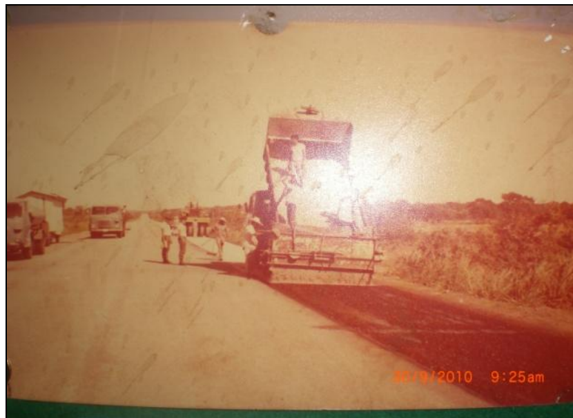
Foto: Construção da estrada de Aquidauana - Corumbá- 1982 Fonte: 4ª Companhia de Engenharia de Combate Mecanizada
