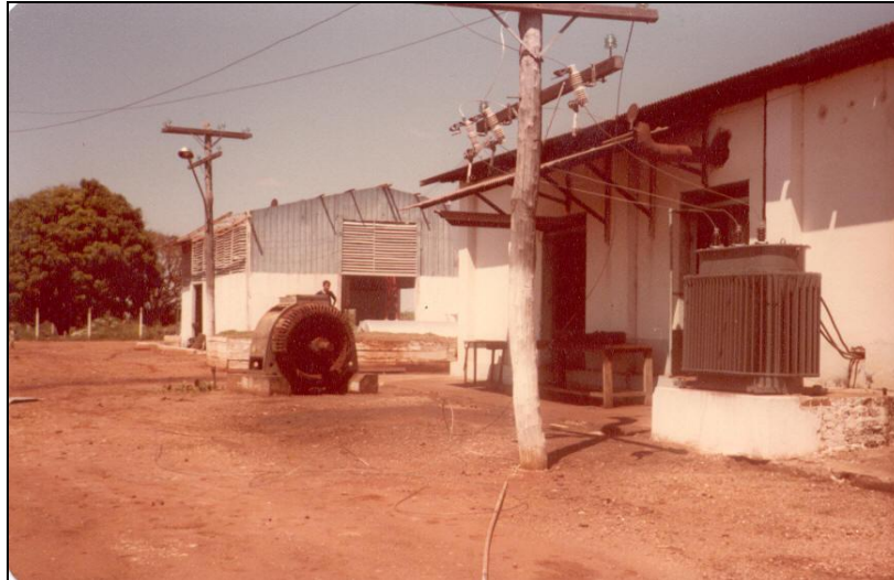
Foto: Área de energia elétrica Fonte: 4ª Companhia de Engenharia de Combate Mecanizada
