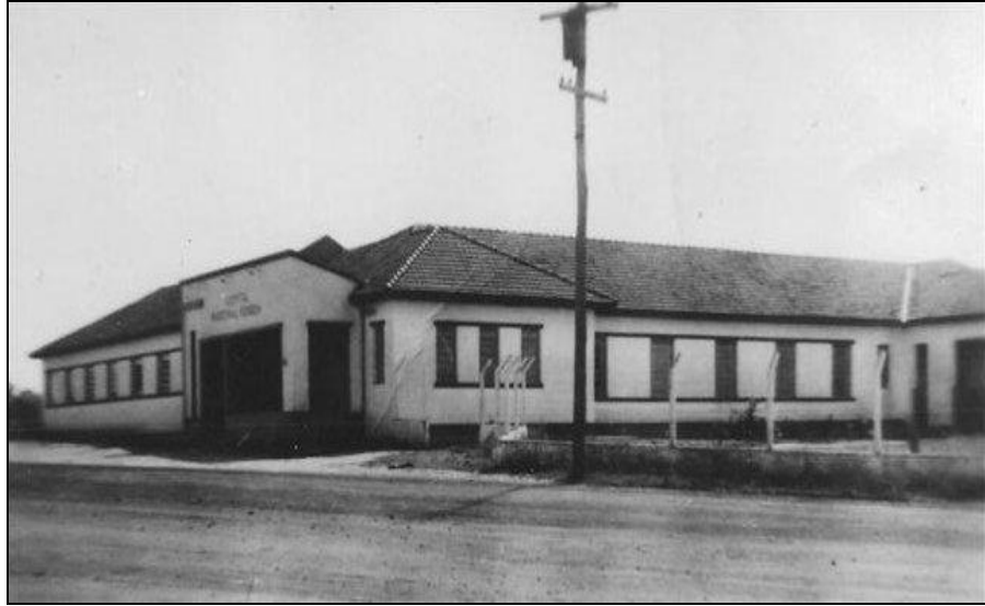
Foto: Hospital Marechal Rondon na década de 1970 Fonte: 4ª Companhia de Engenharia de Combate Mecanizada
