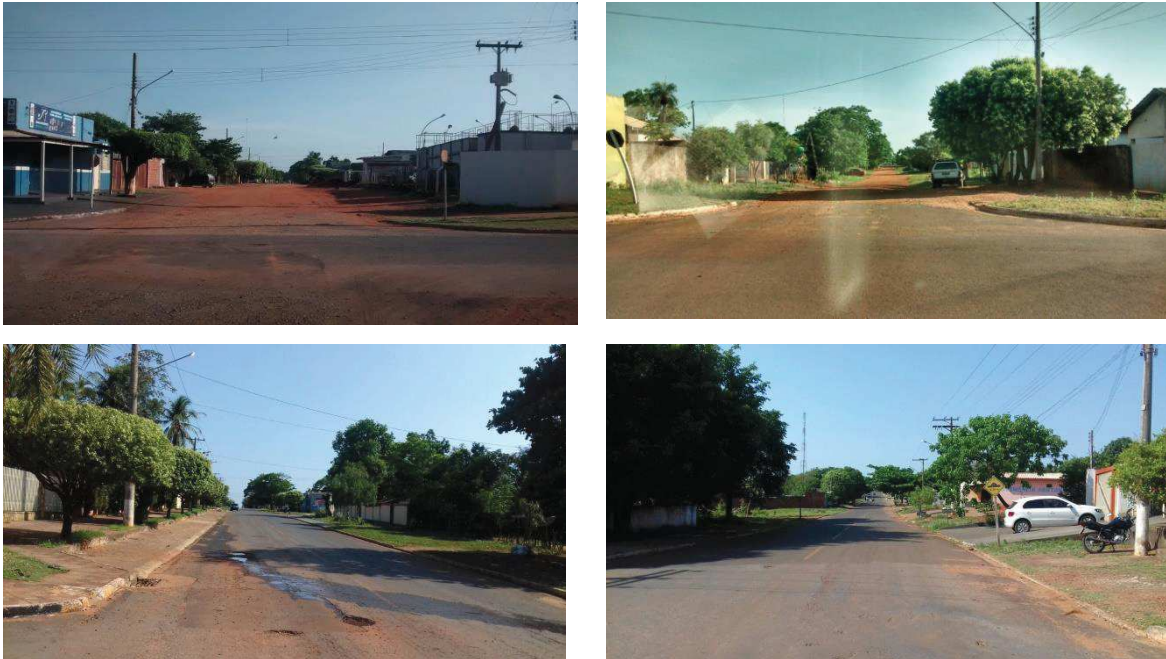
Figura 8: Ruas com pavimentação asfáltica e sem pavimentação asfáltica. Fonte: Pesquisa de Campo, 2016.
