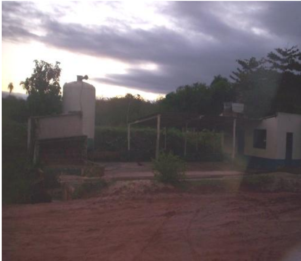
Fig. 07 - lava jato desativado a margens do córrego Valeta
