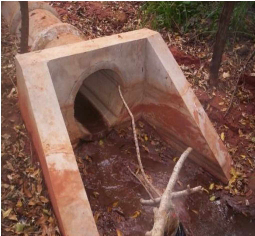
Fig. 04 – Detritos de lava jato de posto de gasolina
