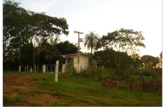
Figura 6. Estação de captação de água na Área da Praia Marly
