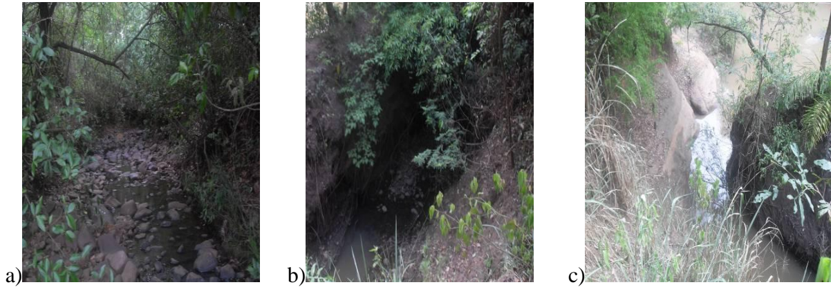
Figura 13: Início da voçoroca na mata ciliar com rochas no fundo do leito e barrancos estabilizadas b : meio da voçoroca dentro da mata com os barrancos estabilizados e no seu interior fluxo de água; c : desembocadura da voçoroca no Rio Santo Antonio com as margens estabilizadas e sem sinal de assoreamento do rio.
