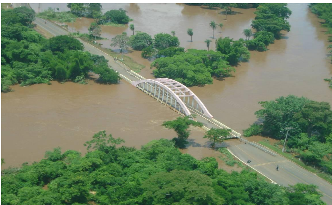
Figura 02 - Inundação da planície do rio Miranda. Cheia observada em 2005 entre os municípios de Guia Lopes da Laguna (margem direita – parte superior da imagem) e Jardim. Ao centro da imagem é possível observar a ponte “Velha”, que liga os dois municípios, quase coberta pelo fluxo da cheia.
