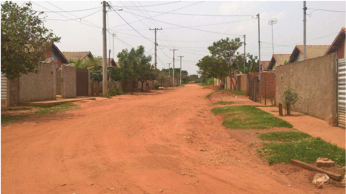
Figura 4: Não-Pavimentação no Conjunto Habitacional Ciriaco Camargo (2016) Fonte: Próprio autor, 2016
