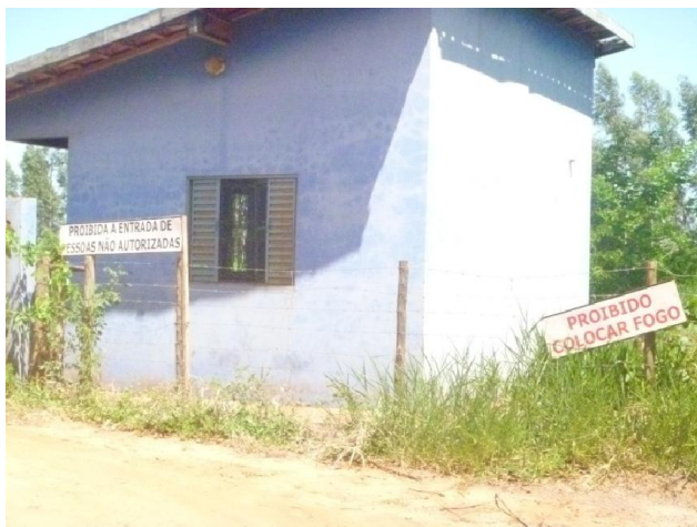
Foto 2 – Guarita da entrada de acesso ao lixão.
