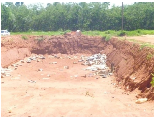
Foto 6 – Vala de Deposição aberta.
