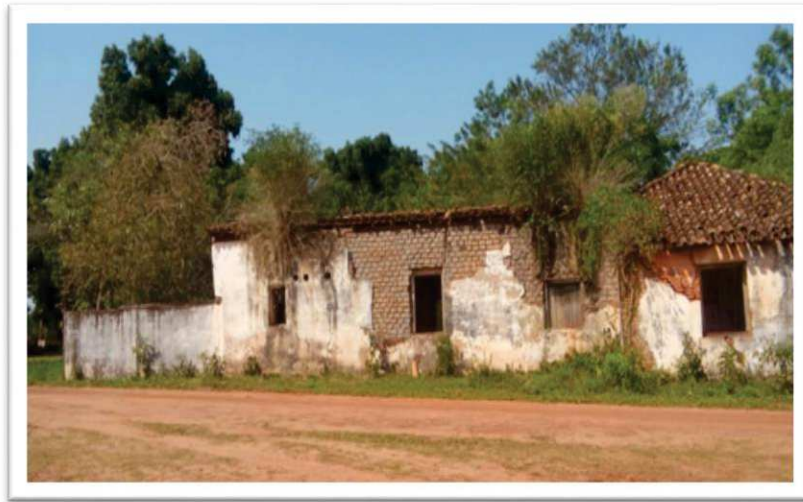
Figura 8: Casarão da sede da fazenda – Núcleo Urbano Fonte: Fogaça (Trabalho de campo - agosto/2016)
