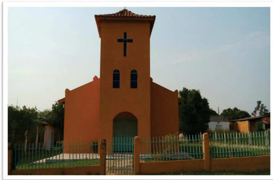
Figura 4: Igreja Católica Bom Jesus – Núcleo Urbano Fonte: Fogaça (Trabalho de campo – agosto/2016)
