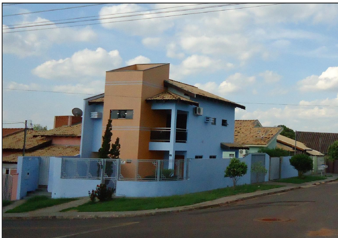
Figura 10- Residência área asfaltada Rua 7 de Setembro
