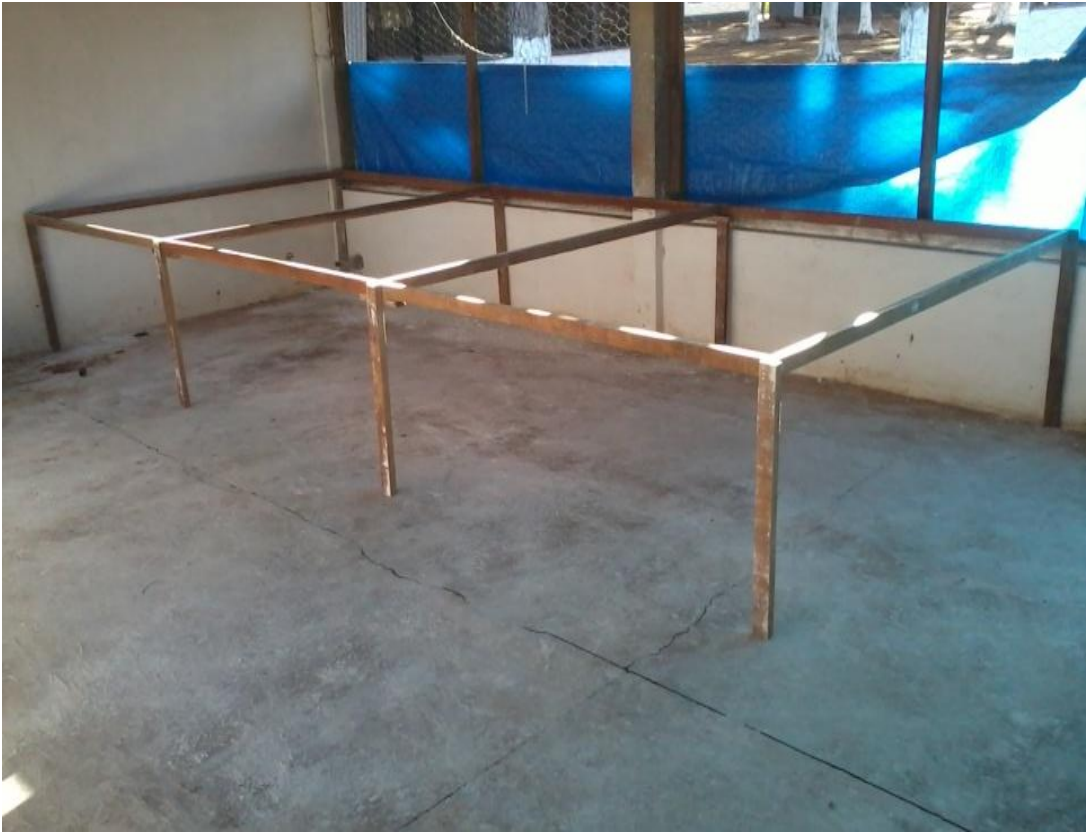
FIGURA 3. Montagem dos Boxes de alojamento das aves
