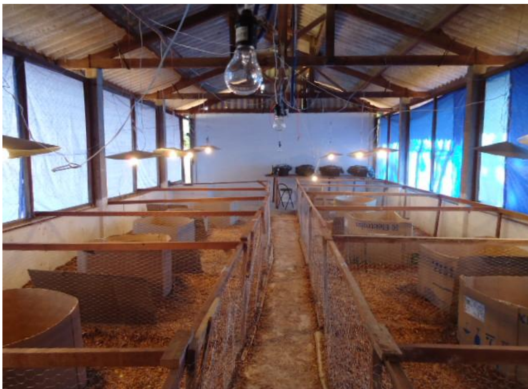
FIGURA 2. Visão interna do aviário
