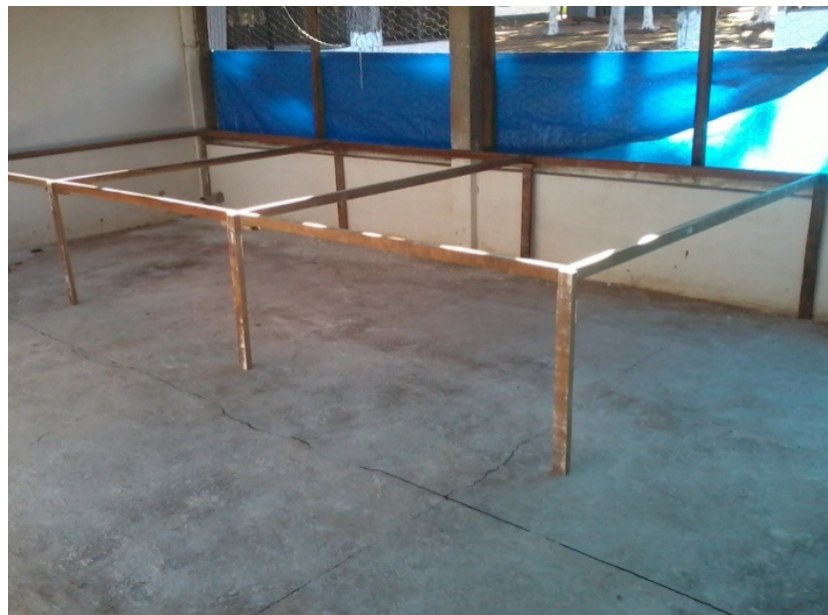
FIGURA 2. Vista interna dos boxes sendo produzidos
