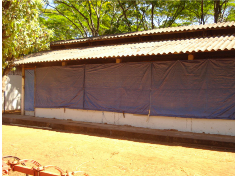
FIGURA 1. Vista externa do aviário
