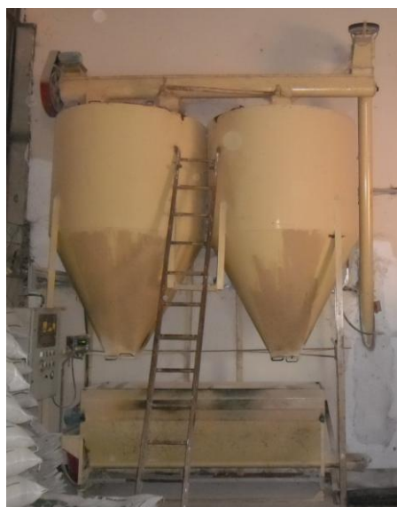
FIGURA 10. Silos para armazenamento de grãos moídos. FORTMIX – Cassilândia/MS, 2012. Fonte: Prado, P. P.
